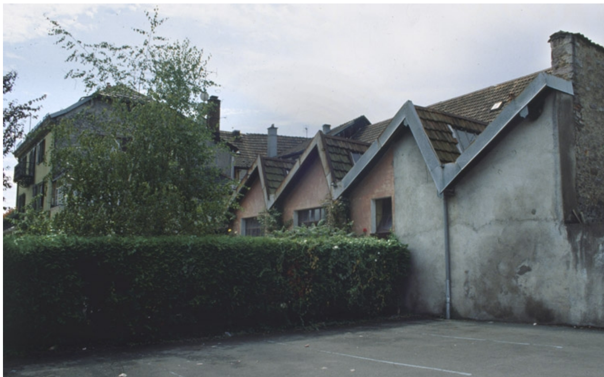
L'atelier de fabrication depuis le nord.
