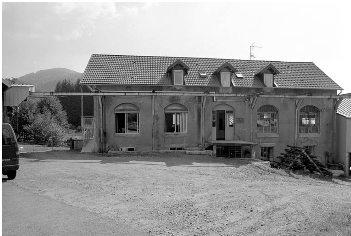
Façade ouest de l'atelier de fabrication primitif.
