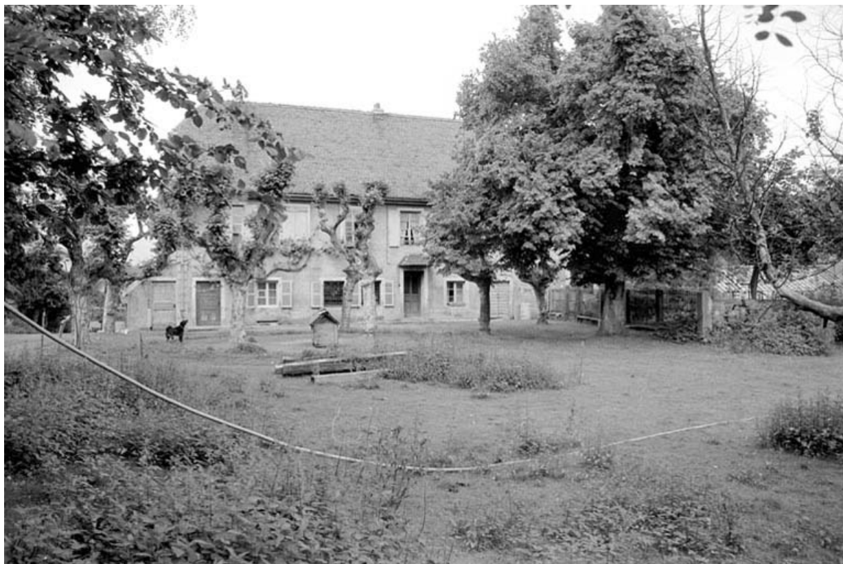
Logement patronal en 1980. SRI. Enquête régionale sur les bâtiments industriels (1979-1981). 90, Lachapelle-sous-Rougemont, 4, 6 rue du Général de Gaulle
