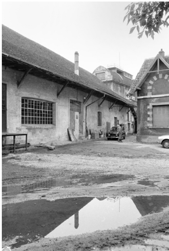
Façade sur cour de l'atelier de nettoyage et d'embouteillage en 1980. SRI. Enquête régionale sur les bâtiments industriels (1979-1981).
