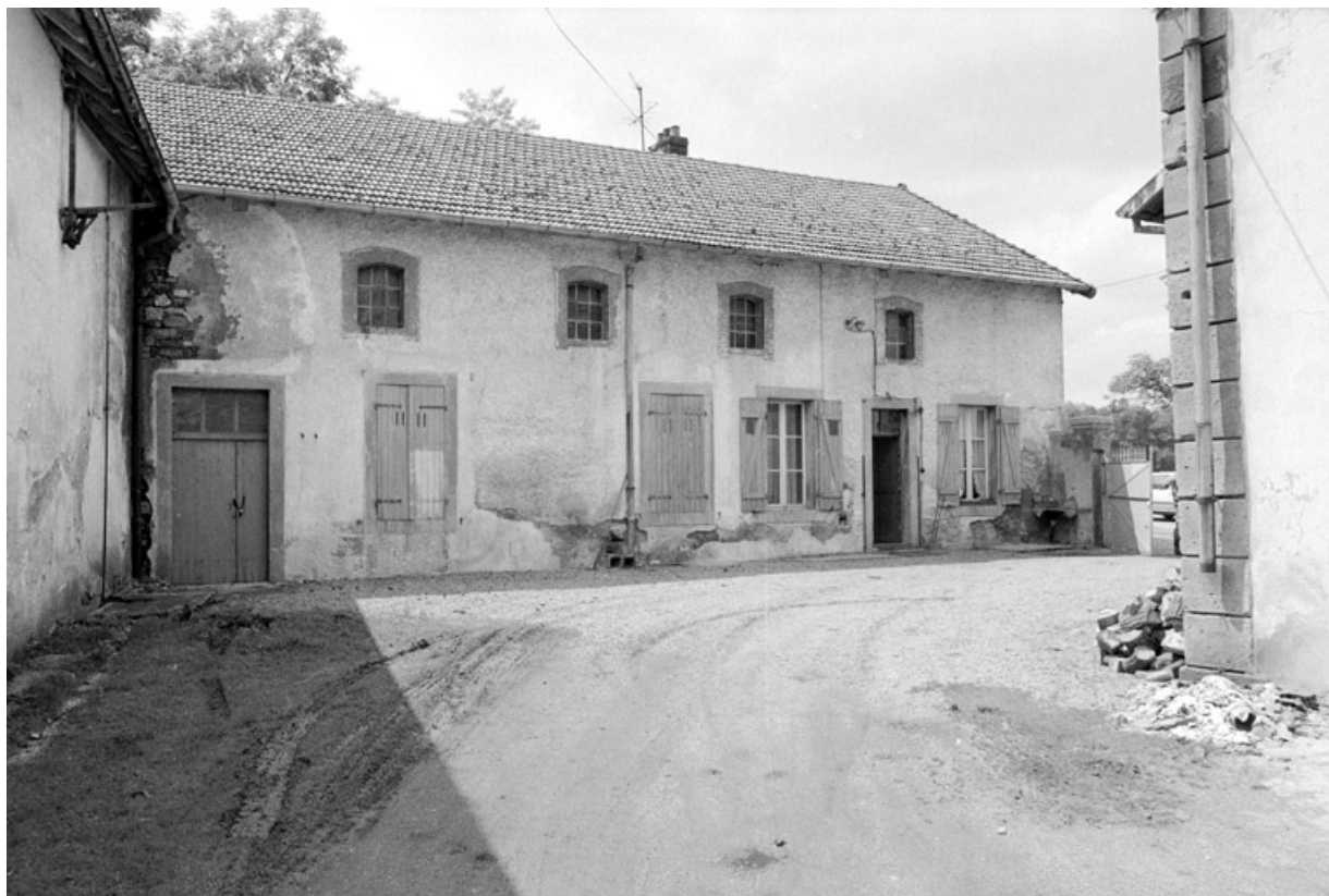
La conciergerie en 1980. SRI. Enquête régionale sur les bâtiments industriels (1979-1981). 90, Lachapelle-sous-Rougemont, 4, 6 rue du Général de Gaulle
