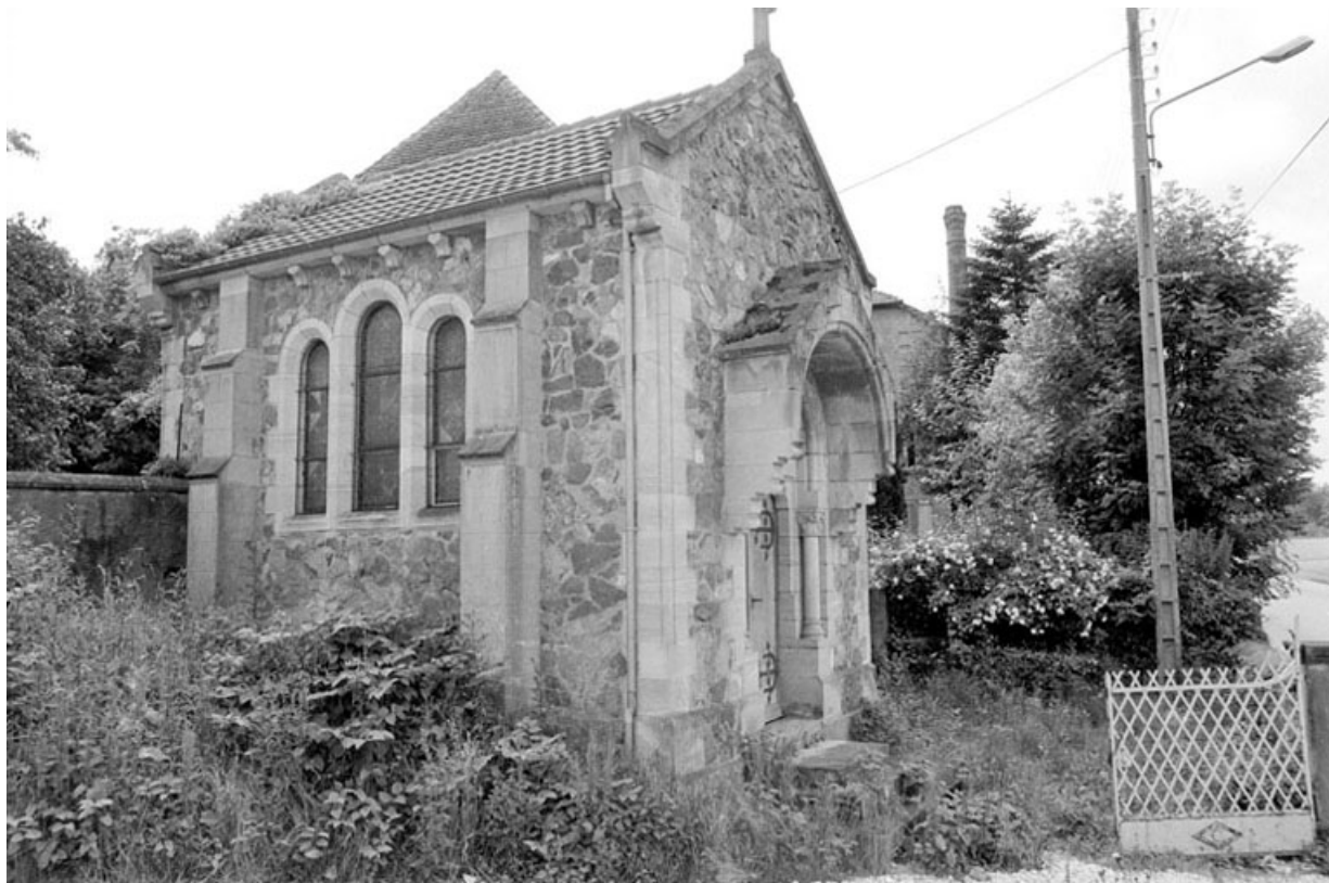
La chapelle vue de trois quarts en 1980. SRI. Enquête régionale sur les bâtiments industriels (1979-1981). 90, Lachapelle-sous-Rougemont, 4, 6 rue du Général de Gaulle
