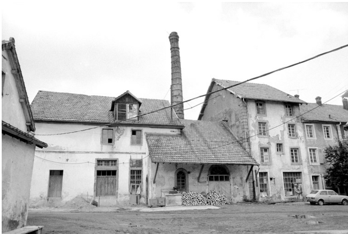
De gauche à droite : atelier de fabrication (eaux gazeuses), salle des machines et chaufferie, et salle de brassage en 1980. SRI. Enquête régionale sur les bâtiments industriels (1979-1981). 90, Lachapelle-sous-Rougemont, 4, 6 rue du Général de Gaulle
