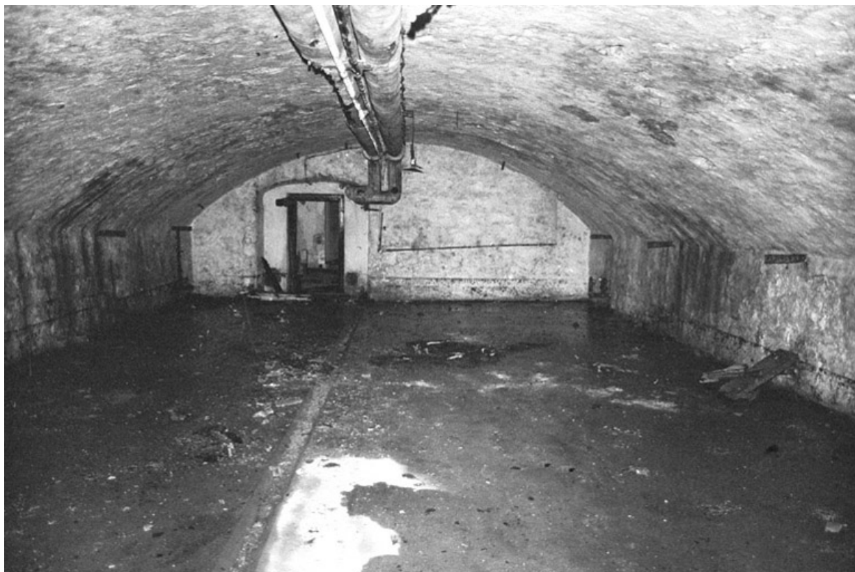
Cave en 1980. SRI. Enquête régionale sur les bâtiments industriels (1979-1981). 90, Lachapelle-sous-Rougemont, 4, 6 rue du Général de Gaulle
