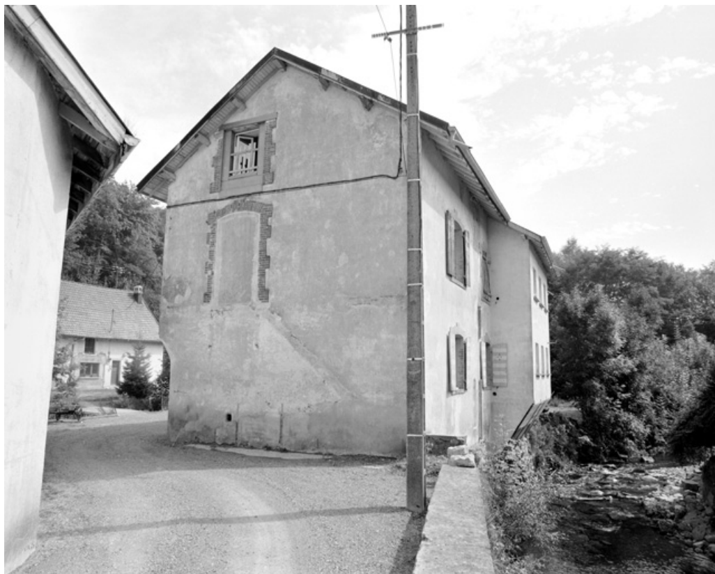
Logement d'ouvriers sur la rivière.
