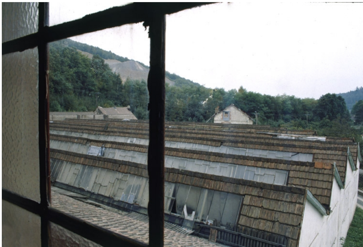
Sheds des salles de tissage depuis le bâtiment à étages.
