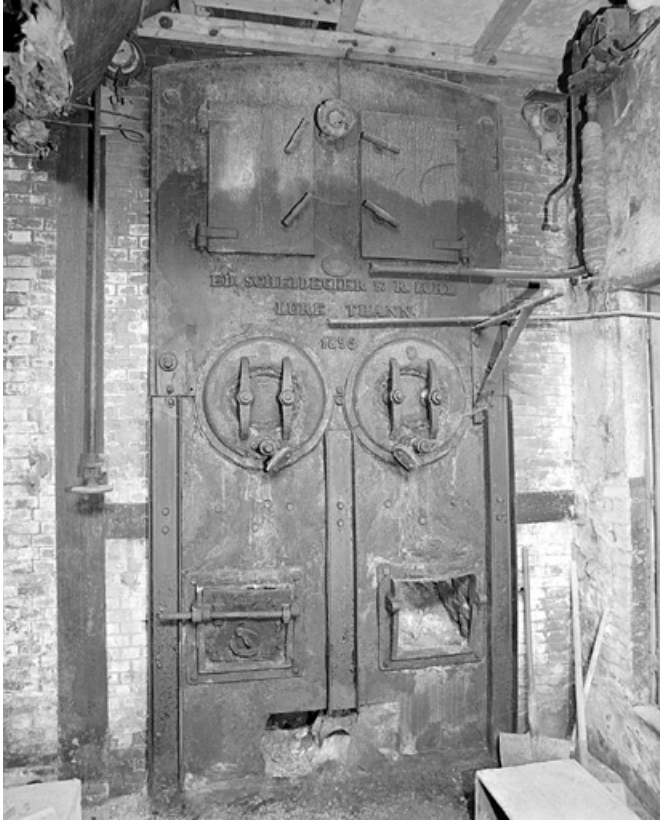
Chaudière de la machine à vapeur.
