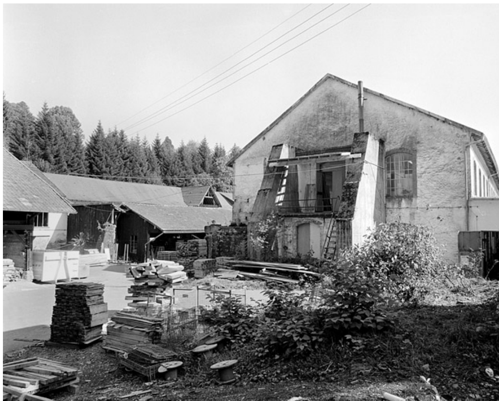
Pignon nord et contreforts de la salle de tissage. Les contreforts ont été placés contre ce pignon afin de réduire les oscillations provoquées par le fonctionnement des métiers à tisser.
