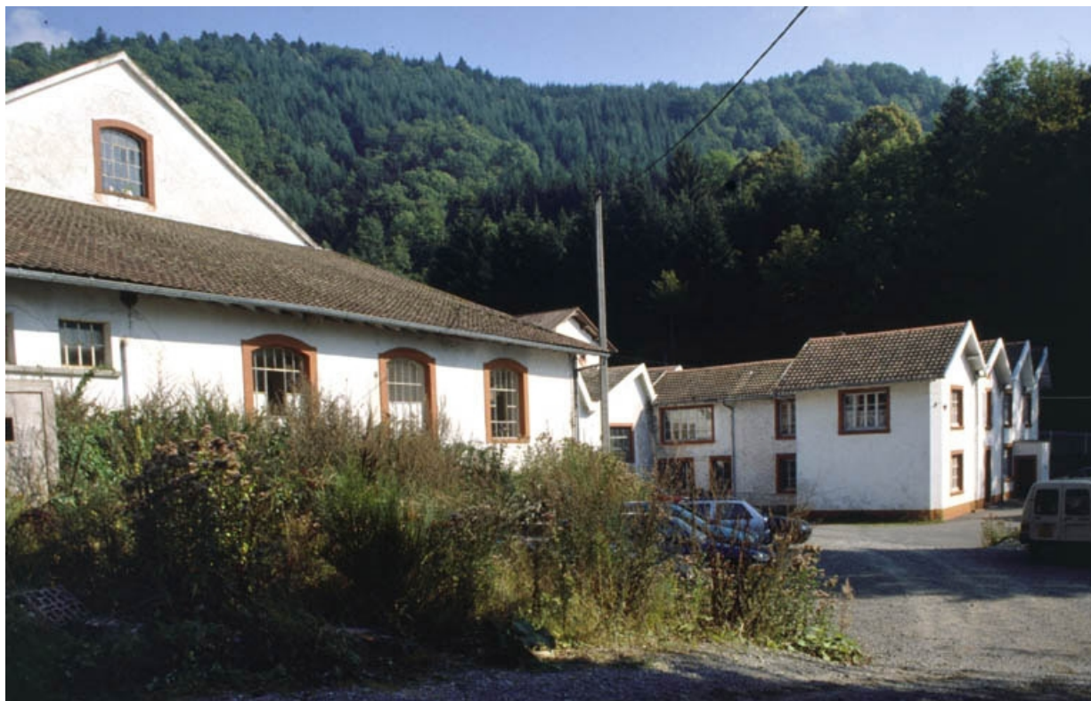
Atelier de fabrication et de réparation, bureaux depuis le sud-ouest.
