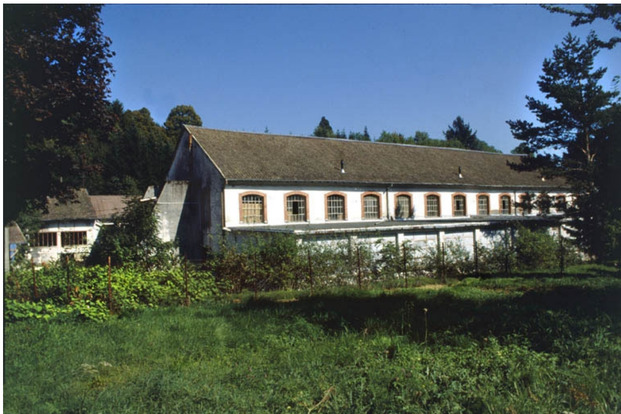
Façade occidentale de la salle de tissage.
