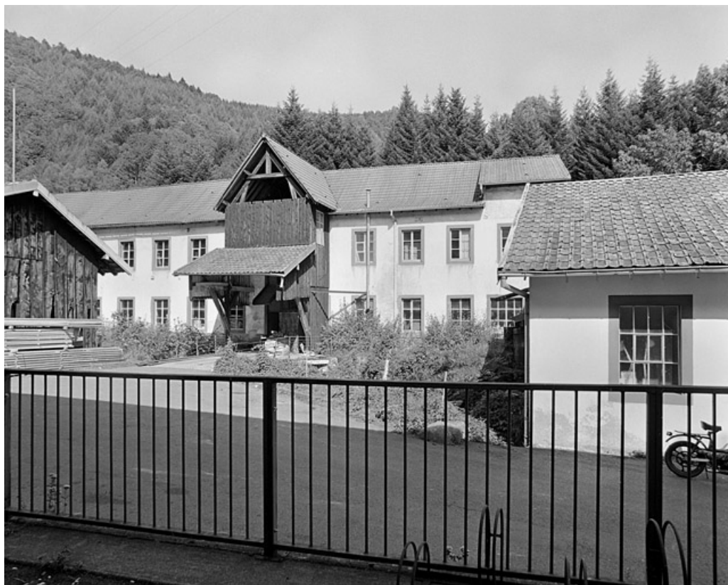
Atelier de fabrication (préparation, bobinage, ourdissage, etc).
