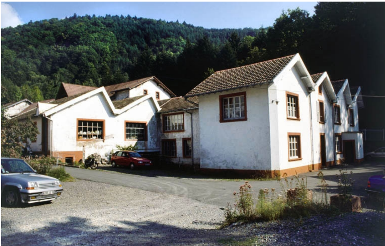
Entrepôt industriel, atelier de réparation et bureaux depuis le sud.
