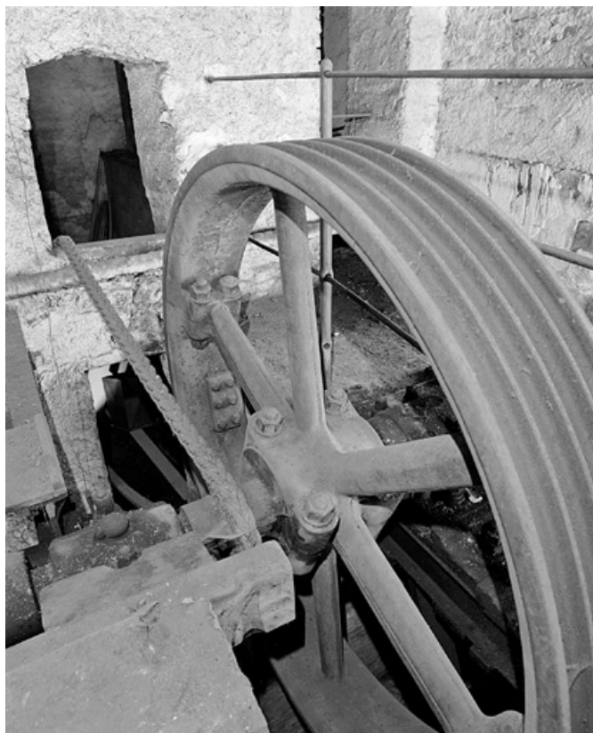
Détail de la roue de transmission de la machine à vapeur. Les gorges de la roue accueillent des câbles en chanvre de section carrée (l'un d'eux est visible contre l'axe de la roue).
