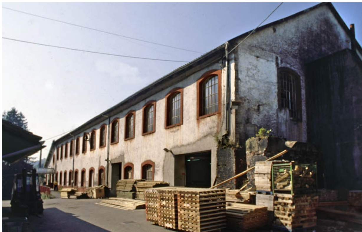
Atelier de fabrication (salle de tissage) depuis le nord.
