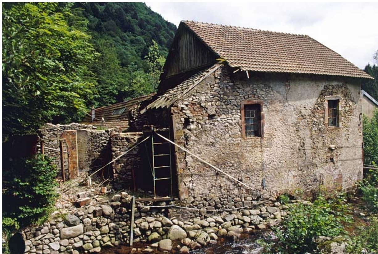
Vestiges de la salle des machines et bâtiment à usage inconnu.
