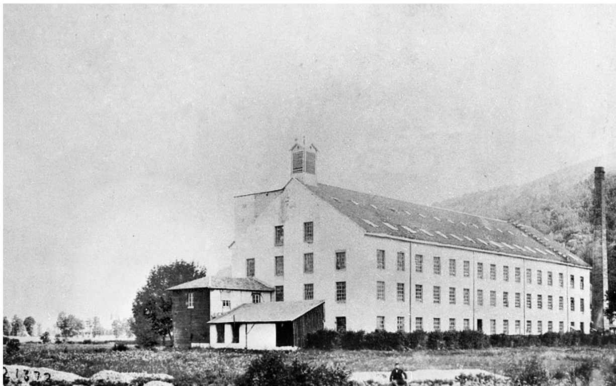
Vue d'ensemble de la filature.
