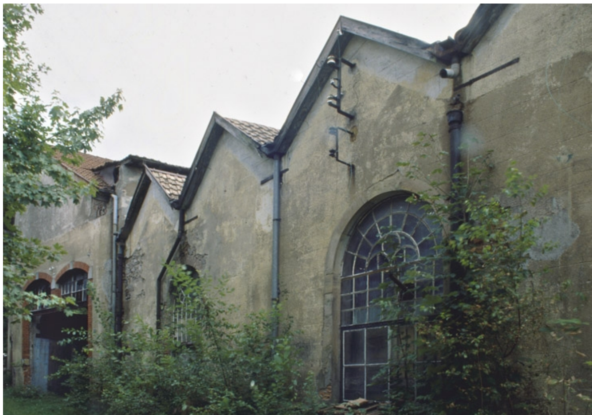
Façade de la salle des machines et de la chaufferie.
