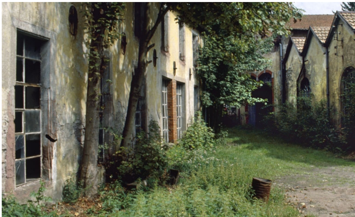
La salle des machines et la chaufferie depuis la cour.
