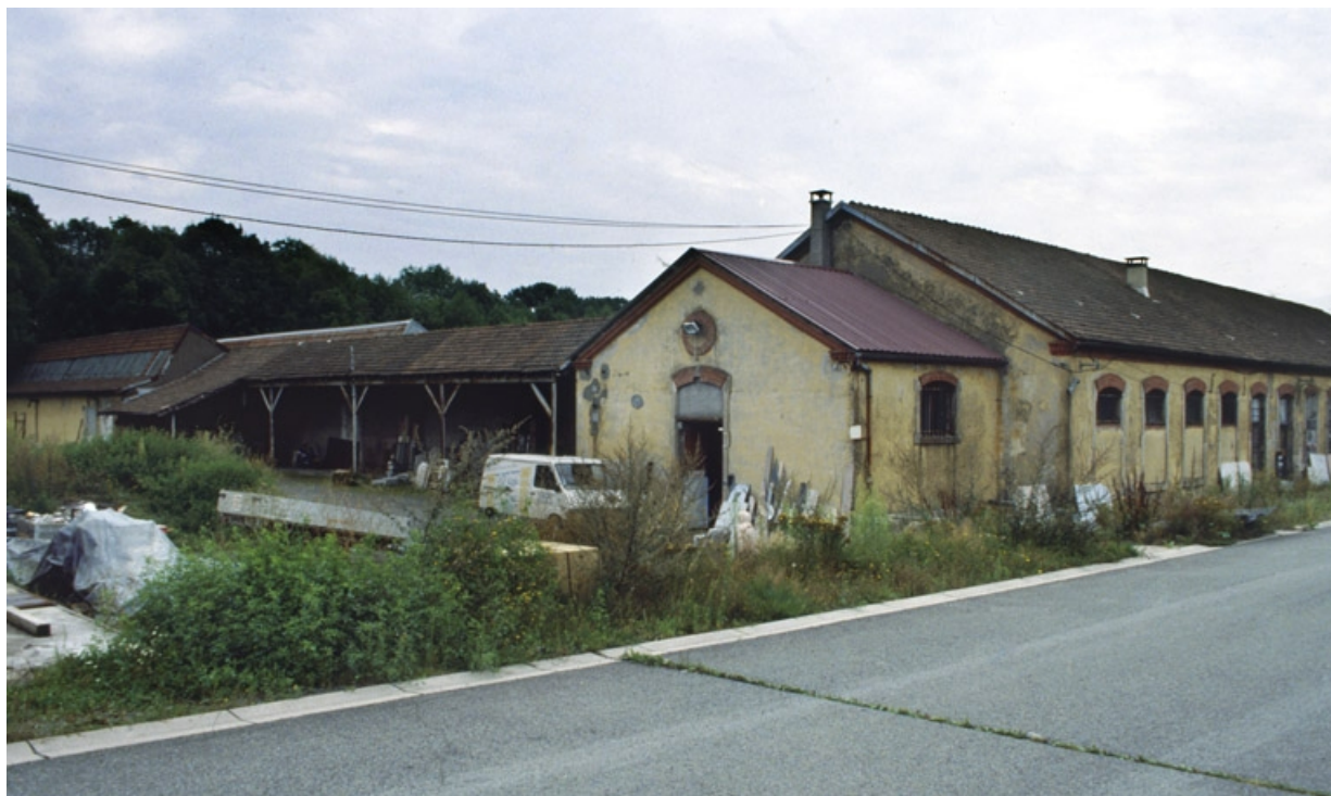
Atelier de filature (à gauche) et magasin industriel (à droite).
