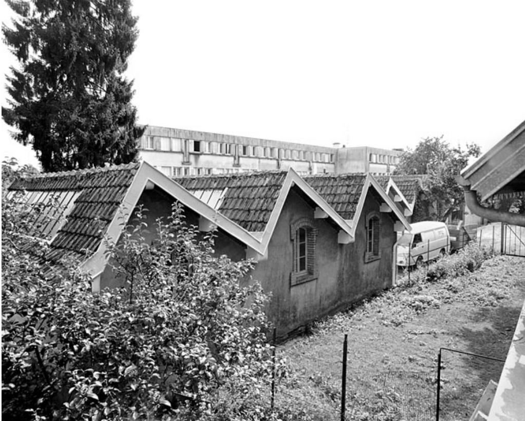
L'atelier de fabrication depuis le nord.
