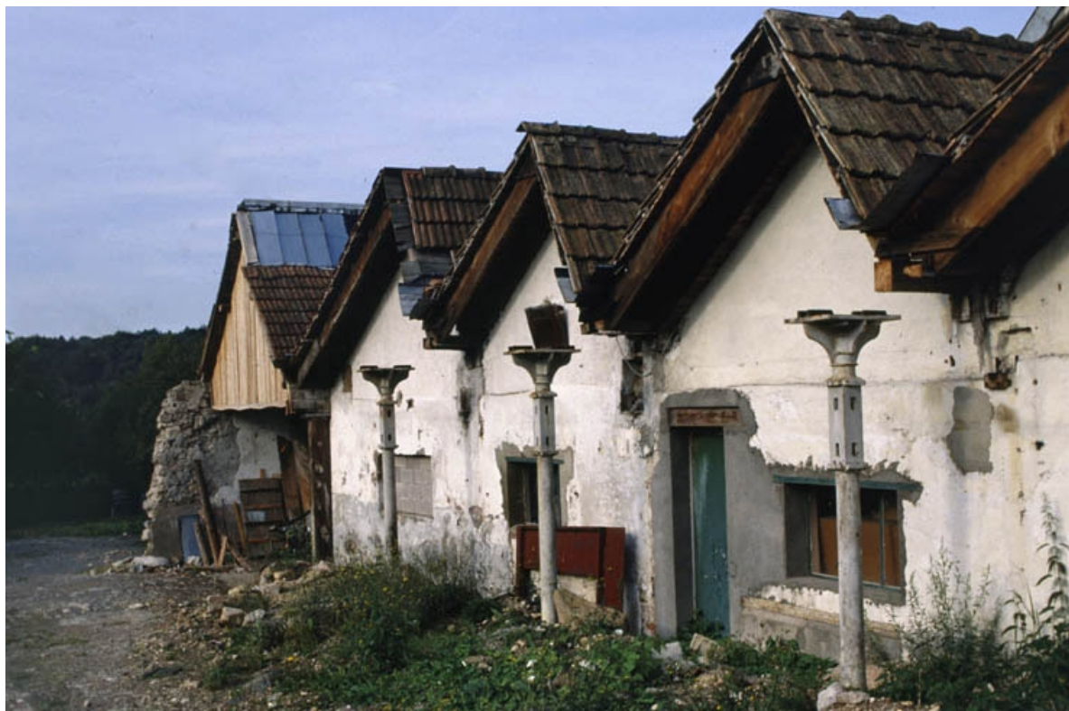
Sheds subsistants de l'atelier de fabrication.
