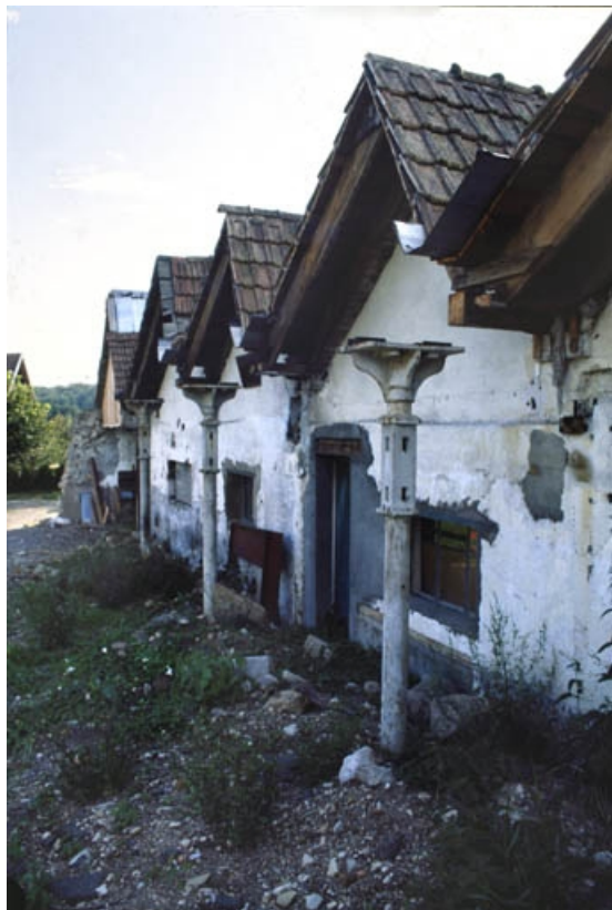
Détail du mur et des poteaux de fonte marquant la limite de destruction de l'atelier de fabrication.
