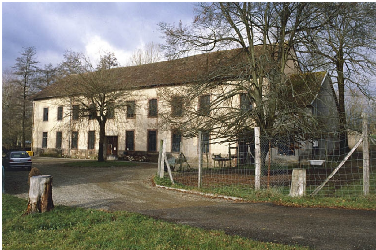
Façade antérieure de l'atelier de fabrication.
