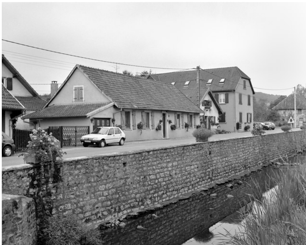
Vue de trois quarts des logements ouvriers.
