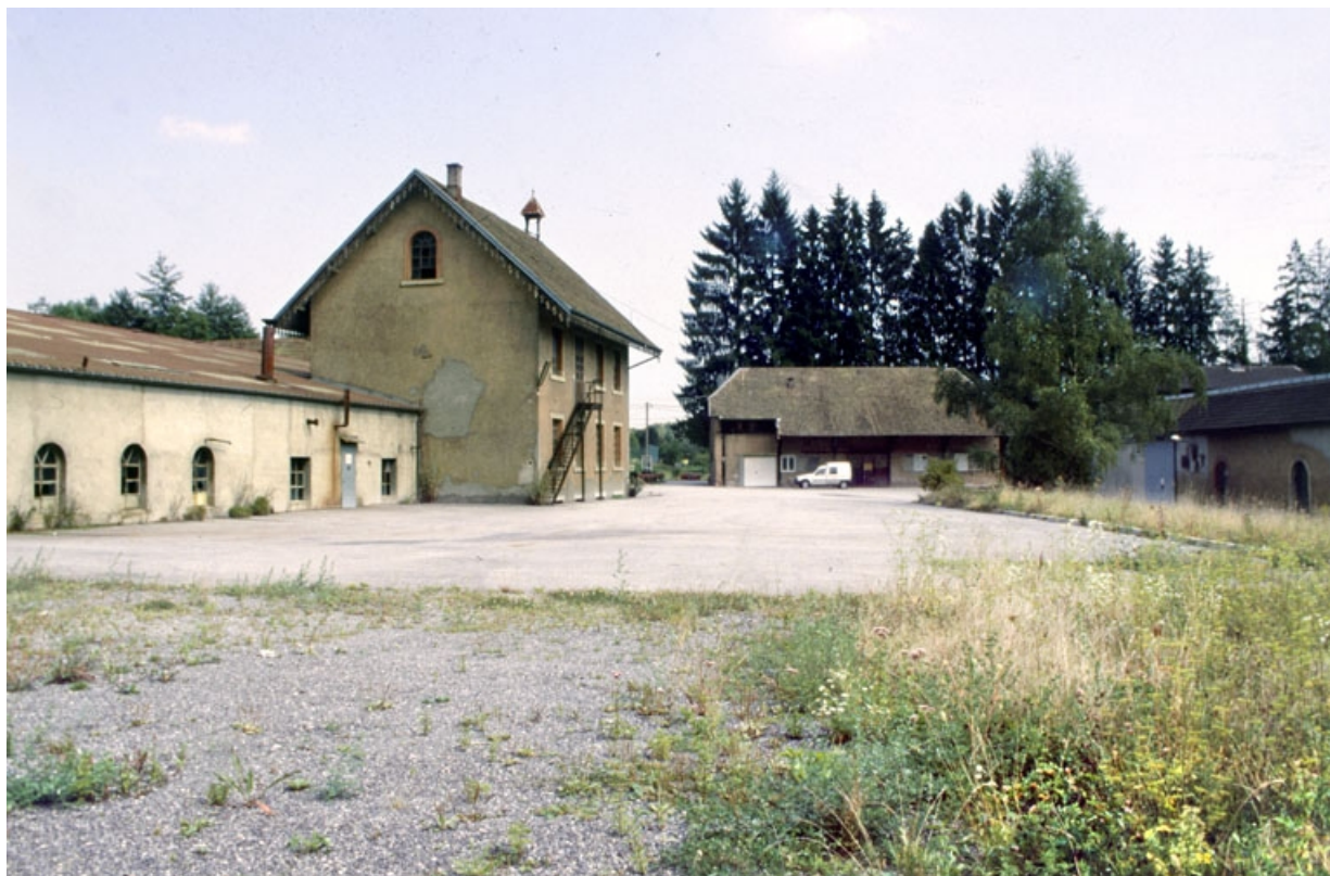
Vue de la cour depuis l'emplacement de l'ancienne salle des machines.
