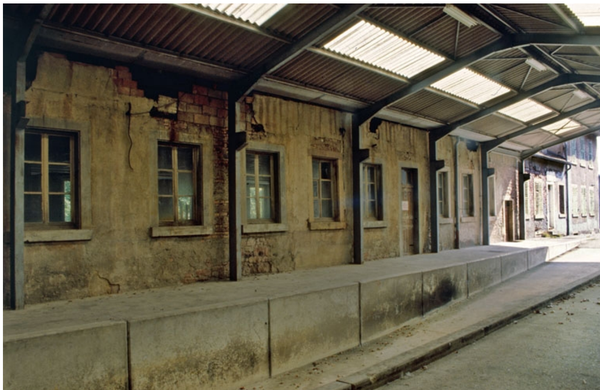
Quai couvert établi contre l'ancien tissage.
