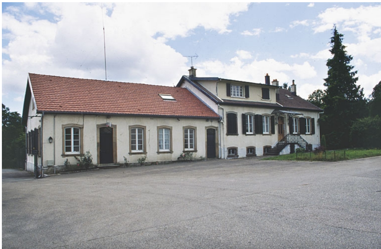
Les bureaux attenants au logement de contremaître.
