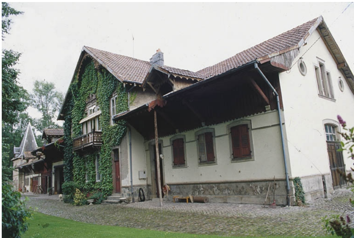
Façade antérieure de la ferme vue de trois quarts.
