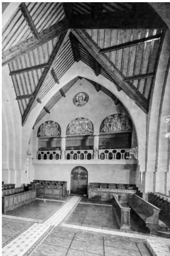
Détail de l'entrée et de la tribune de la chapelle, entre 1930 et 1944. 89, Sens, 67 rue Carnot
