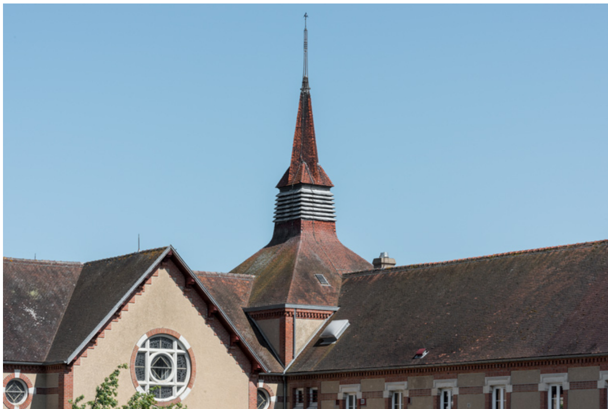
Détail du couvrement de la chapelle et du campanile.
