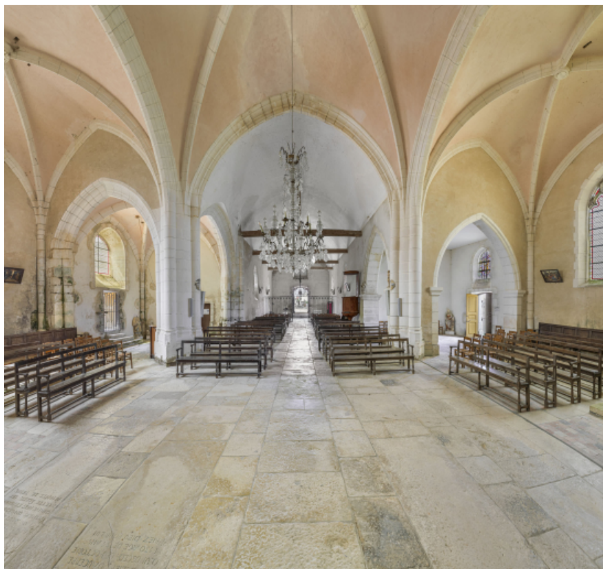
Vue d'ensemble de l'intérieur de l'église depuis le chœur.
