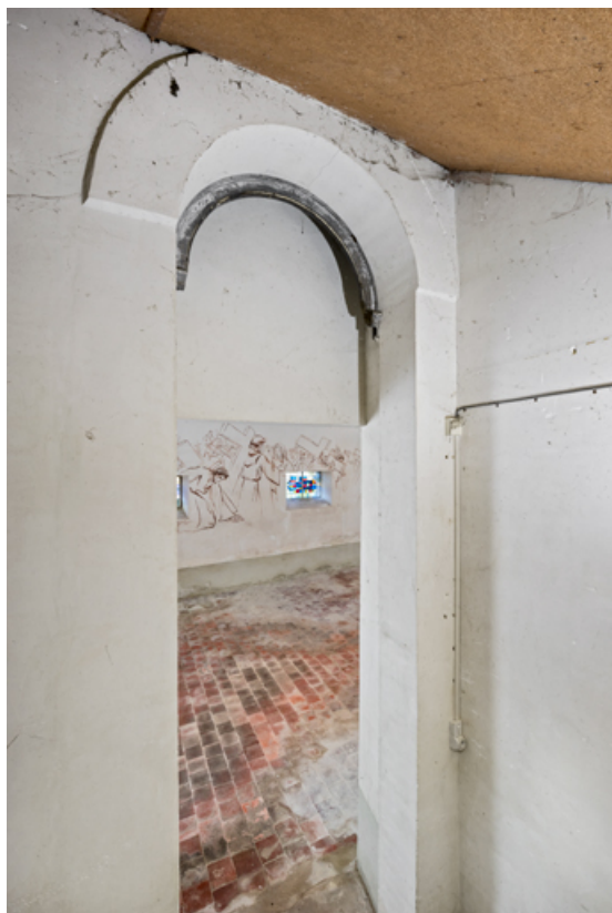
Vue de la baie de la sacristie.
