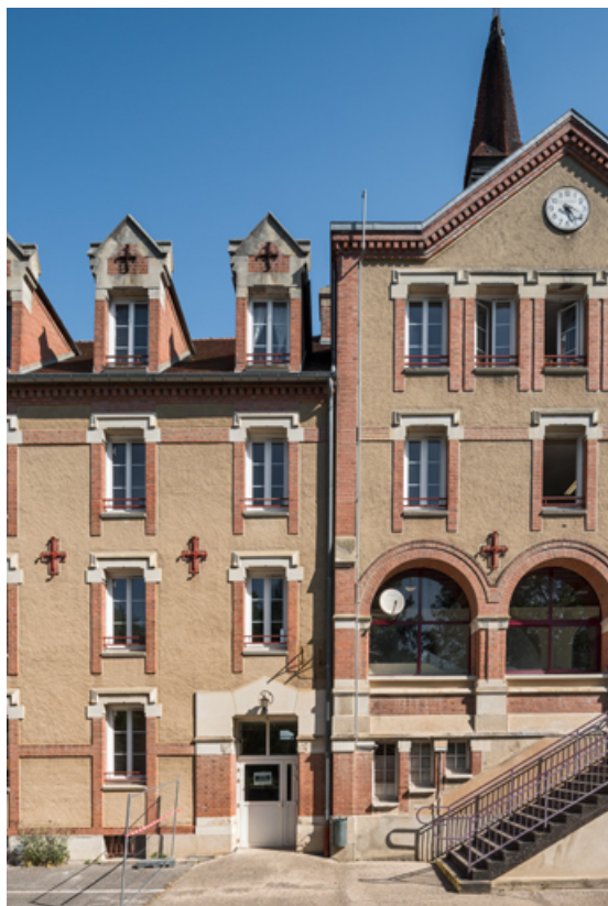
Détail de la jonction entre l'aile ouest et l'aile centrale. 89, Sens, 67 rue Carnot
