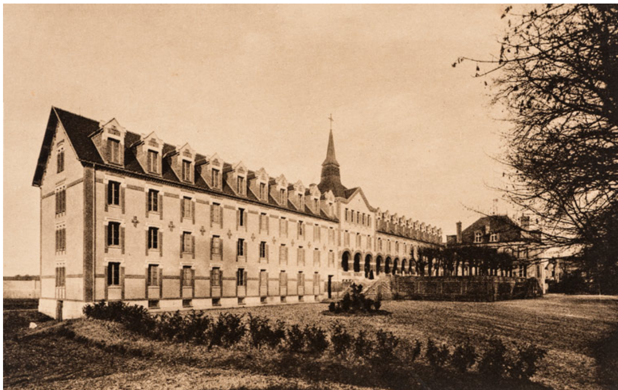
Vue d'ensemble de la façade principale du grand séminaire depuis le parc, entre 1934 et 1944.
