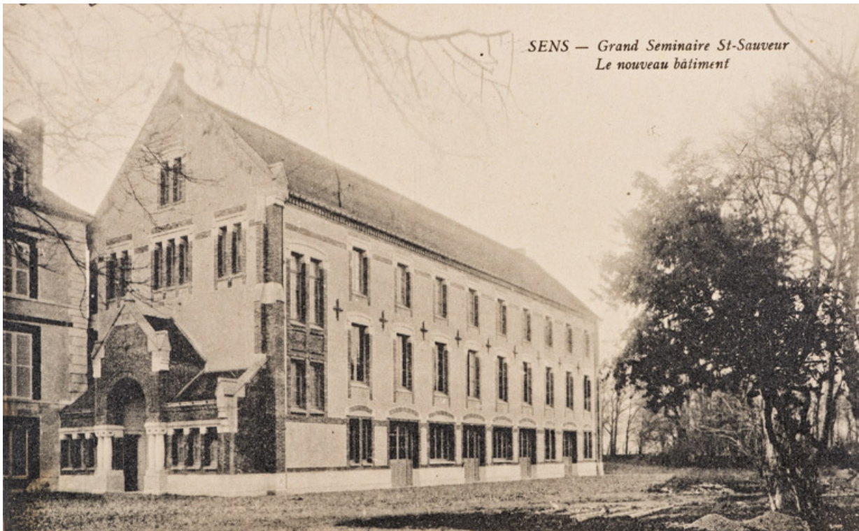
Vue des façades est et nord du nouveau bâtiment lors de sa construction en 1921.
