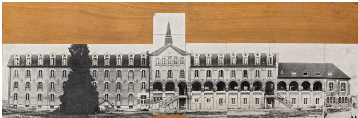
Vue panoramique du séminaire lors des travaux de transformation en Centre d'Aide par le Travail en 1975. 89, Sens, 67 rue Carnot
