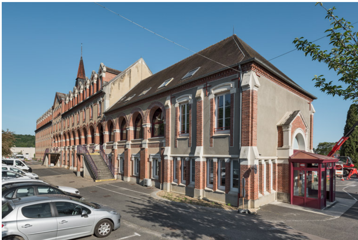
Vue des façades sud et est, avec l'entrée principale.
