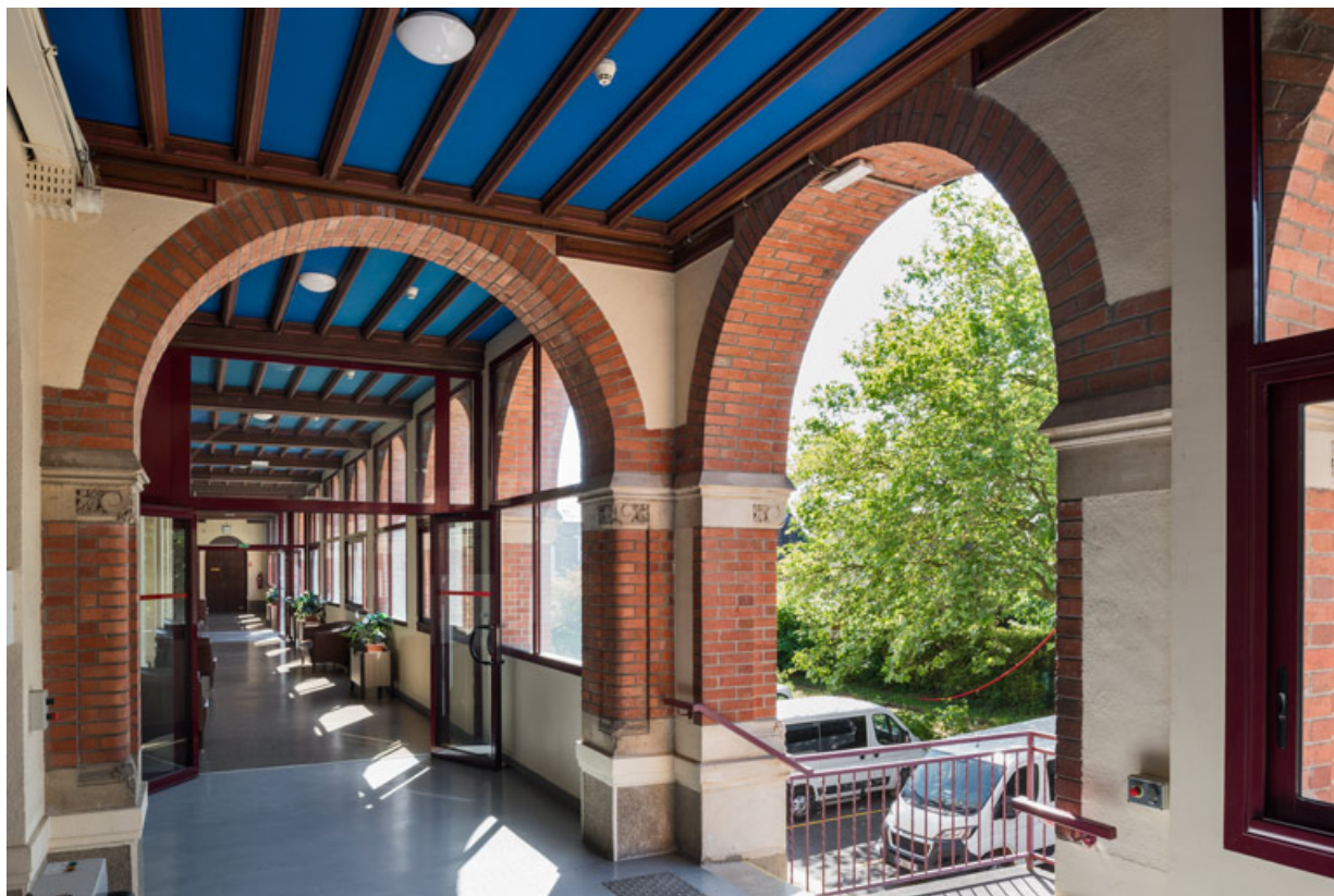
Vue d'ensemble de la galerie ouverte, de trois-quarts.
