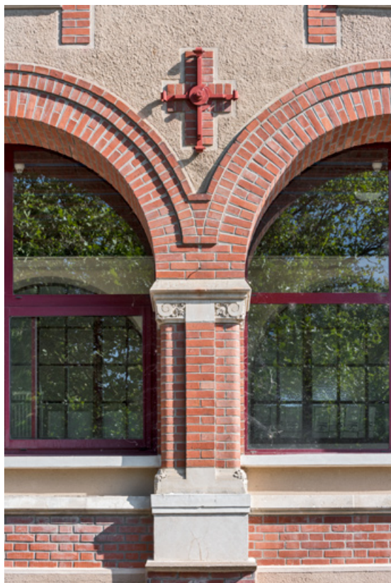
Détail d'une colonne de la galerie ouverte.
