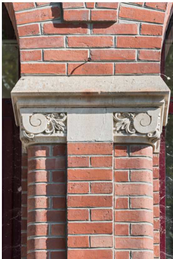
Détail du chapiteau d'inspiration ionique dans la galerie ouverte, de face. 89, Sens, 67 rue Carnot
