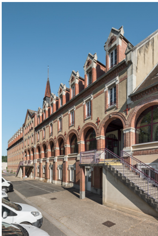
Vue de la façade sud (de trois-quarts).
