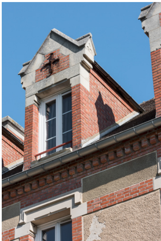
Détail des lucarnes réalisées lors de l'aménagement de l'étage sous comble. 89, Sens, 67 rue Carnot
