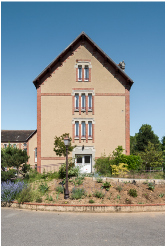
Vue du pignon ouest.
