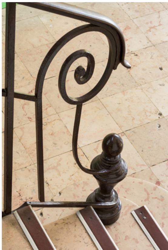
Détail du garde-corps de l'escalier.
