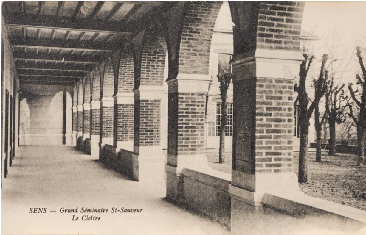
Vue de la galerie ouverte en direction de l'est, entre 1921 et 1934.
