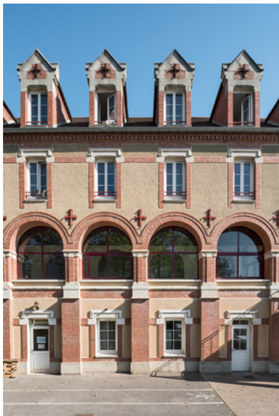
Vue de quatre travées de la façade sud, avec la galerie jouant le rôle de cloître. 89, Sens, 67 rue Carnot
