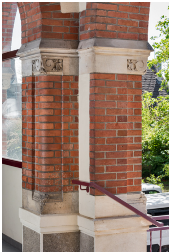
Détail de la colonne de la galerie ouverte (vue depuis la galerie). 89, Sens, 67 rue Carnot
