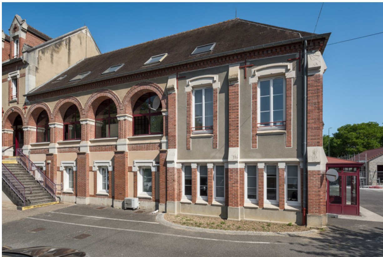
Vue de la façade sud de la partie reconstruite.
