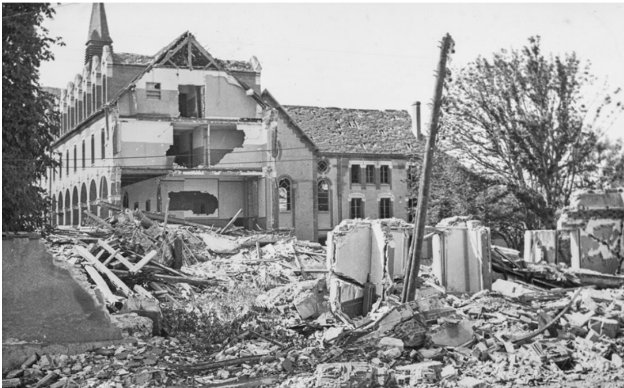
Vue de la partie est du séminaire détruite par les bombardements en 1944. 89, Sens, 67 rue Carnot
