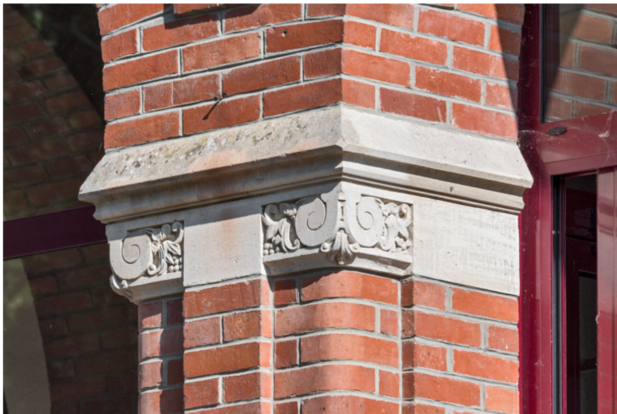
Détail du chapiteau d'inspiration ionique dans la galerie ouverte, de trois-quarts. 89, Sens, 67 rue Carnot
