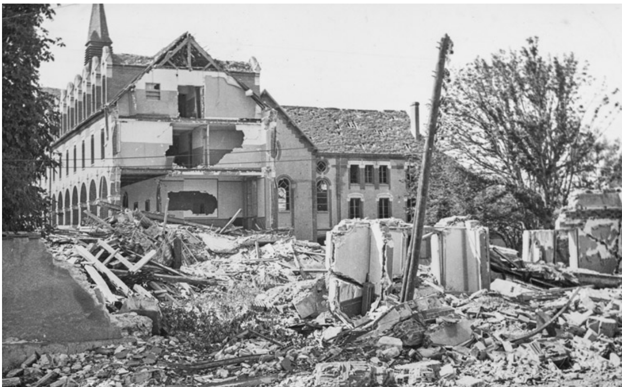
Vue de la partie est du séminaire détruite par les bombardements en 1944.
