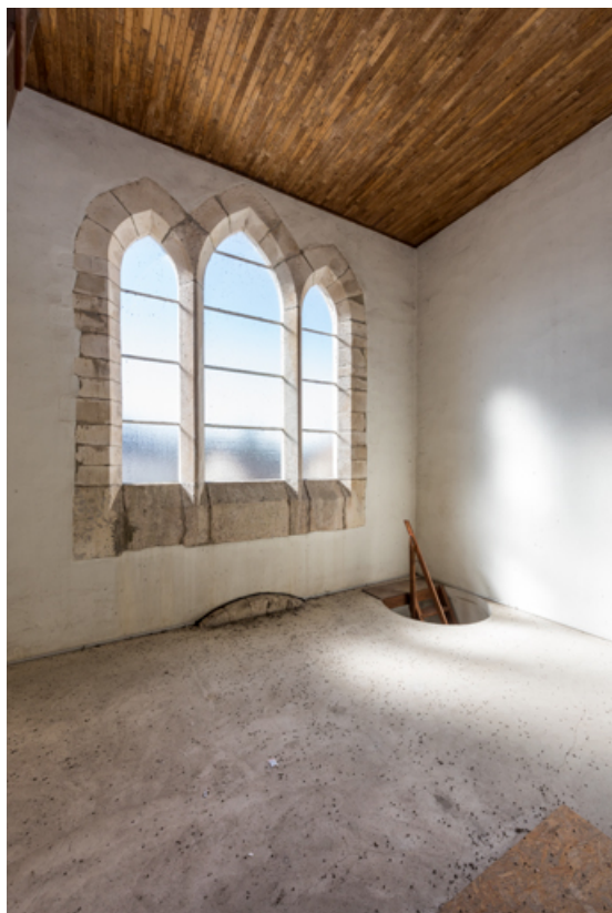
Vue intérieure de la baie à trois lancettes de la tribune.
