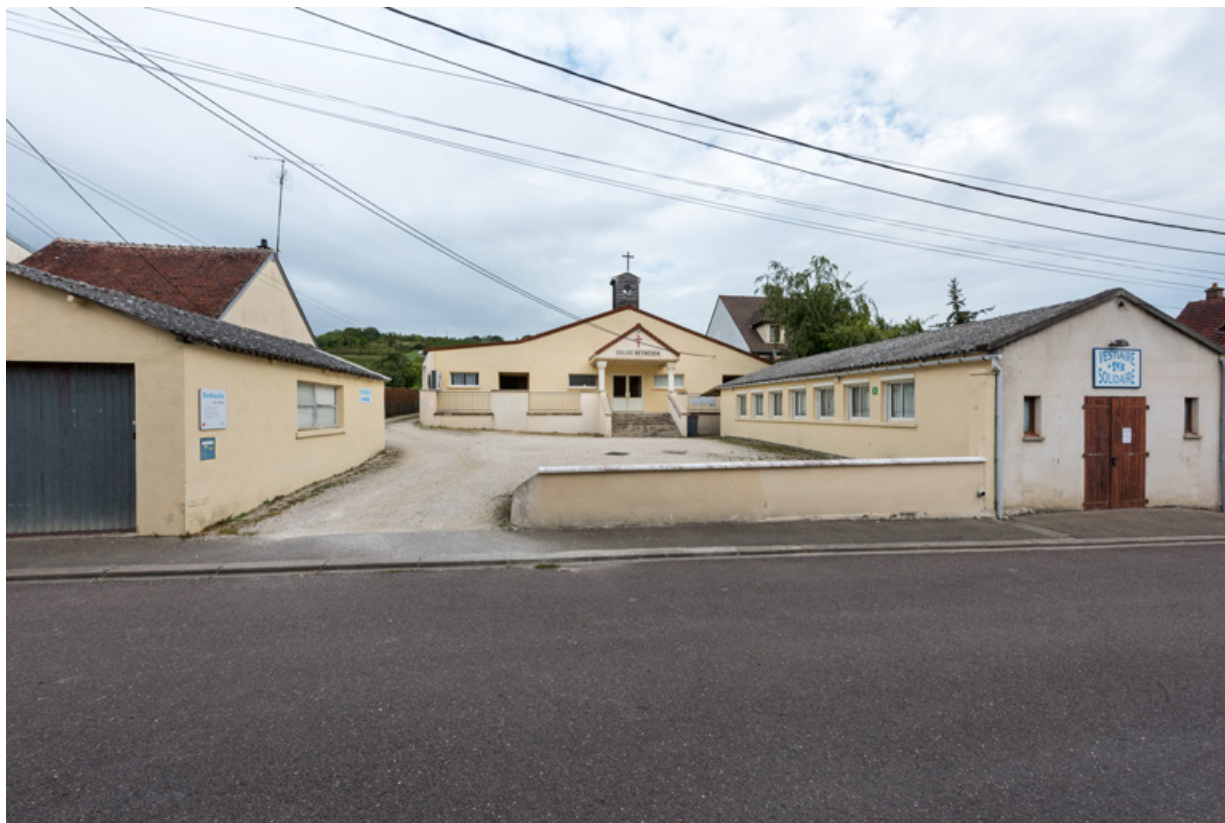
Garage ; usine de menuiserie devenue salle de culte ; entrepôt industriel. Vue d'ensemble.
