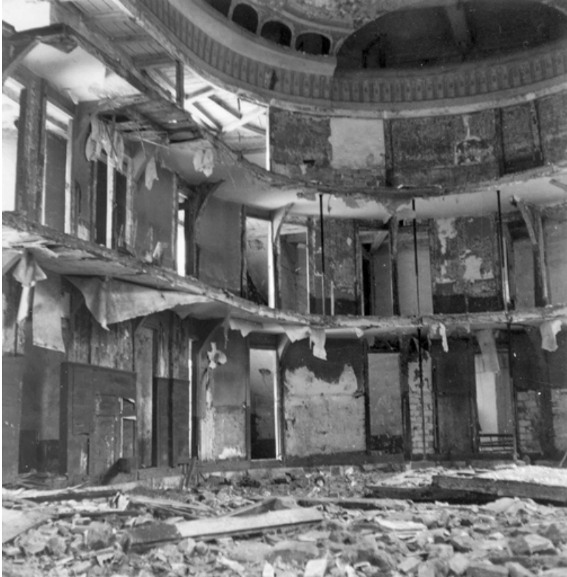
[Destruction de l'ancien théâtre : vue intérieure]. S.d. [1er trimestre 1960 ?]. 89, Auxerre
