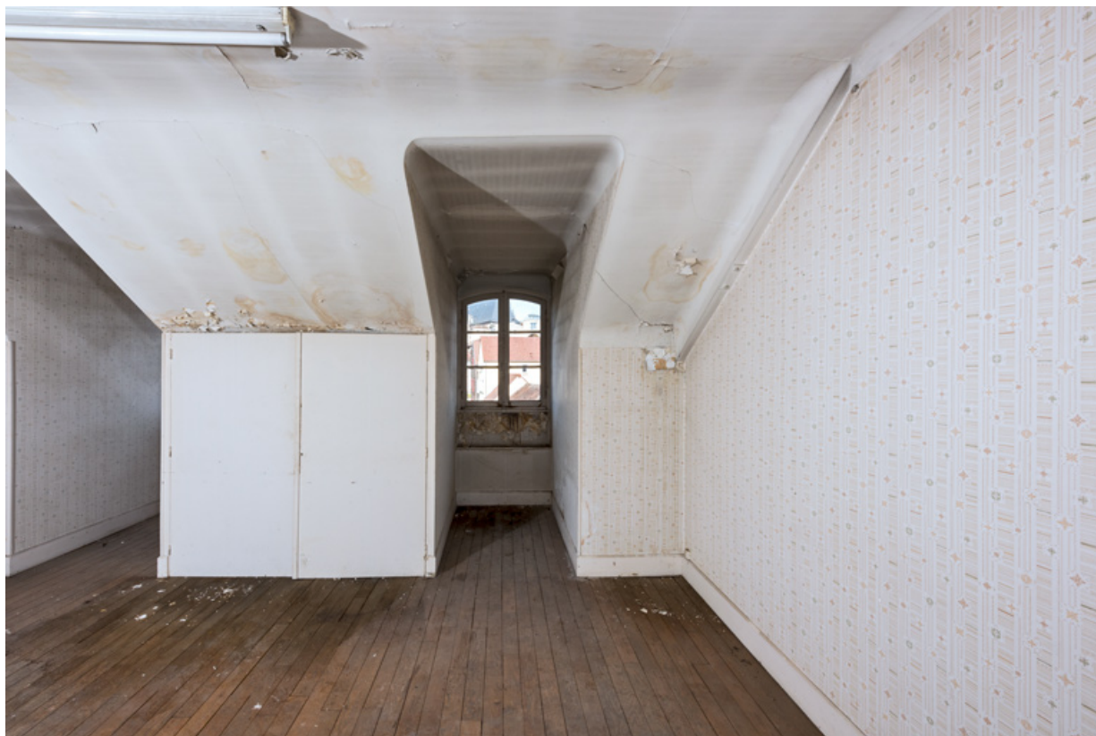
2e étage : grand bureau. 89, Auxerre, 9 rue Milliaux
