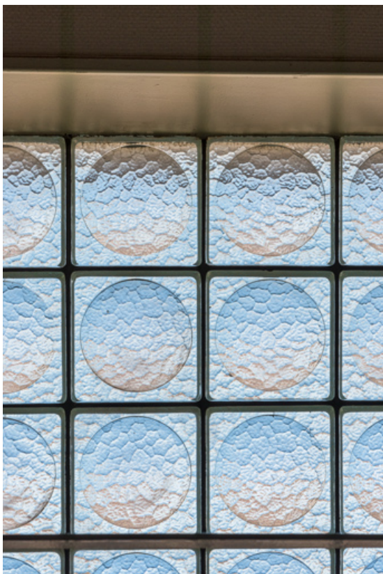
Cage d'escalier : détail des pavés de verre.
