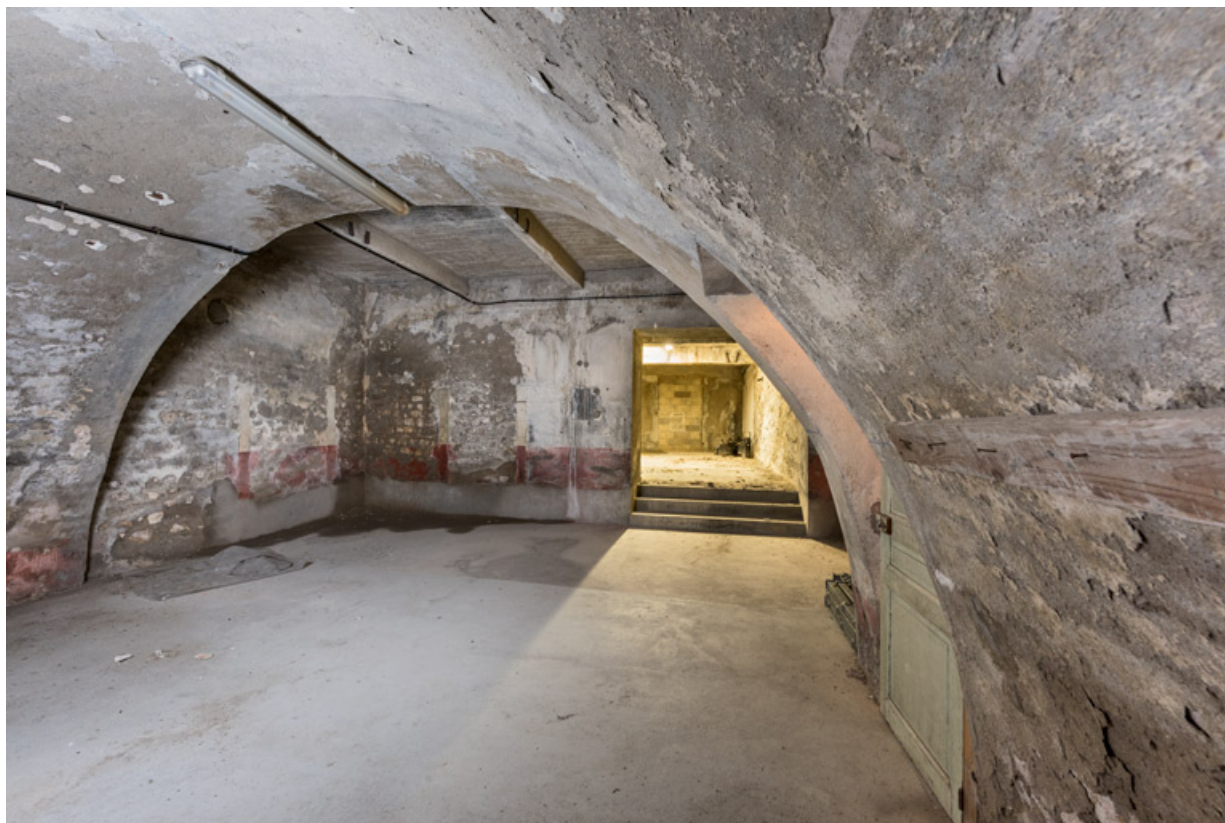
Caves nord : vue depuis l'ouest.
