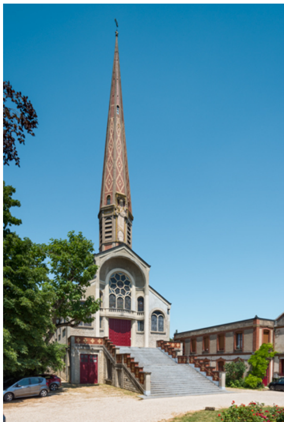
Eglise et chapelle. Vue de trois quarts.
