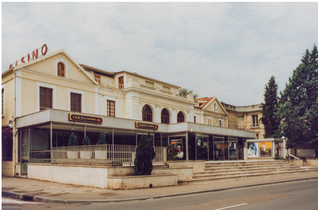
[Façades du Casino Auxerrois : côté boulevard du 11 Novembre]. S.d. [décennie 1990]. 89, Auxerre, 1 boulevard du 11 Novembre
