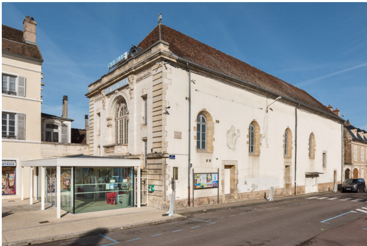
Façades antérieure et latérale droite.
