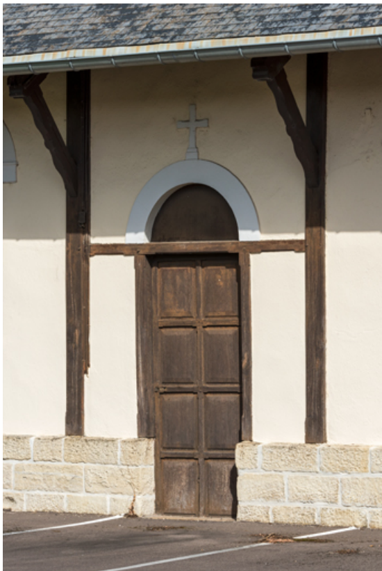
Porte de la façade ouest. Vue de trois quarts.
