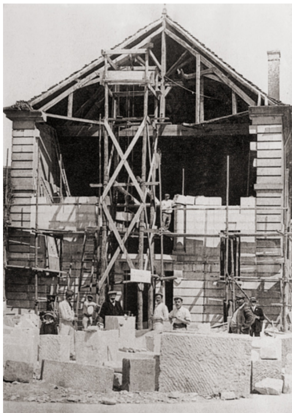
[Construction de la façade du théâtre d'Avallon]. S.d. [1910].
