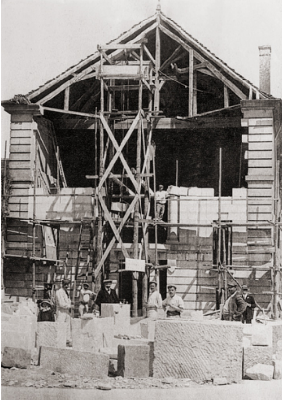
[Construction de la façade du théâtre d'Avallon]. S.d. [1910]. 89, Avallon, 1 rue du Maréchal Foch
