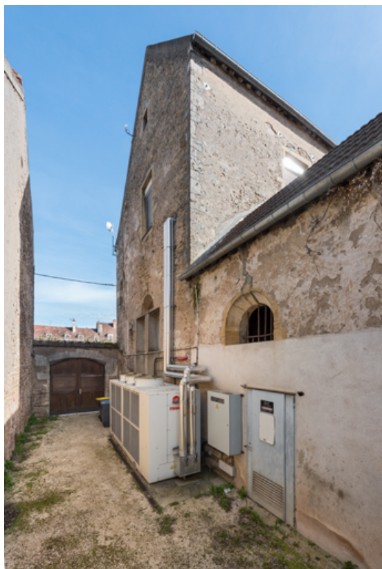
Façade postérieure, vue en enfilade.
