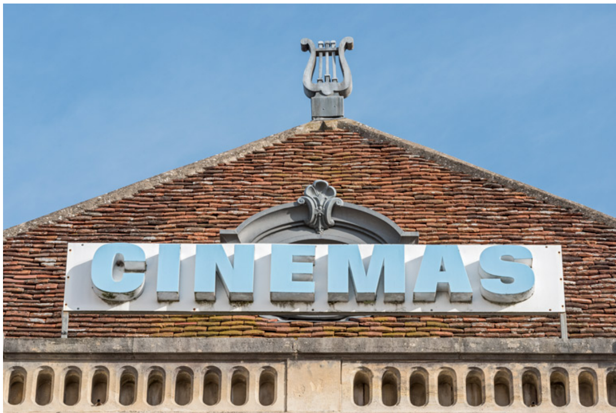
Façade antérieure : partie supérieure avec enseigne et épi de faitage en forme de lyre.
