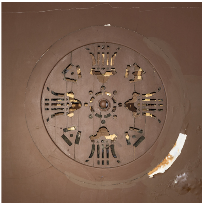
Ancien système d'aération au plafond.
