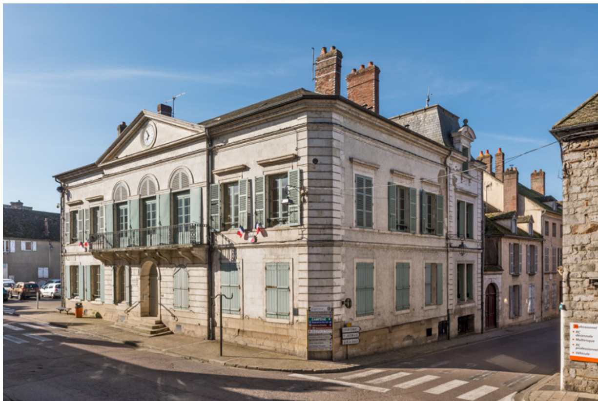
Vue d'ensemble, de trois quarts droite. 89, Villeneuve-sur-Yonne, 25 rue Carnot
