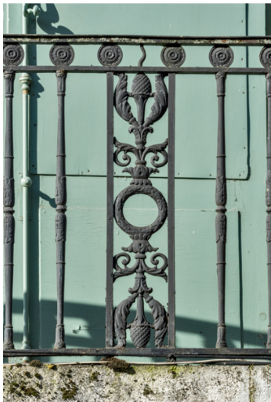
Façade antérieure, avant-corps central : détail du garde-corps en fonte du balcon. 89, Villeneuve-sur-Yonne, 25 rue Carnot
