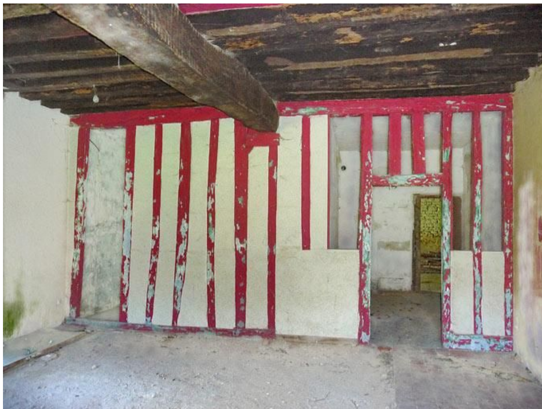
Première pièce du logis du rez-de-chaussée de la grange, cloison en pans de bois.
