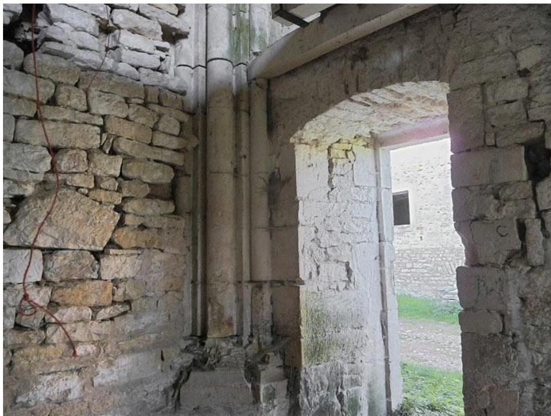
Chapelle, corps postérieur : départ des colonnes de l'angle nord-ouest.
