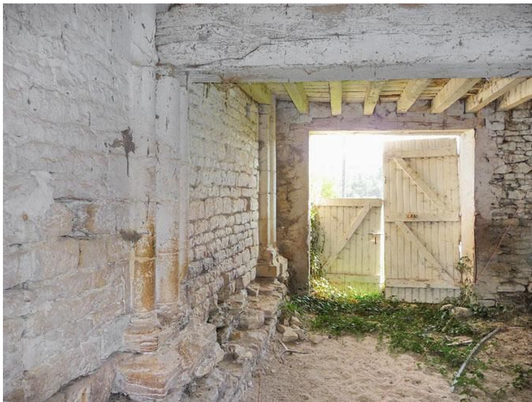
Chapelle, corps postérieur : colonnes engagées du mur sud.
