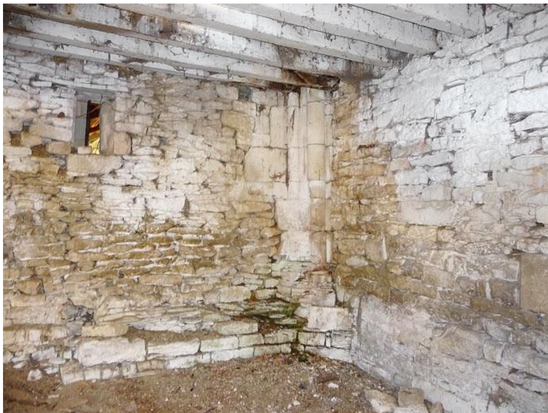
Chapelle, corps postérieur : vue de l'angle sud-ouest.
