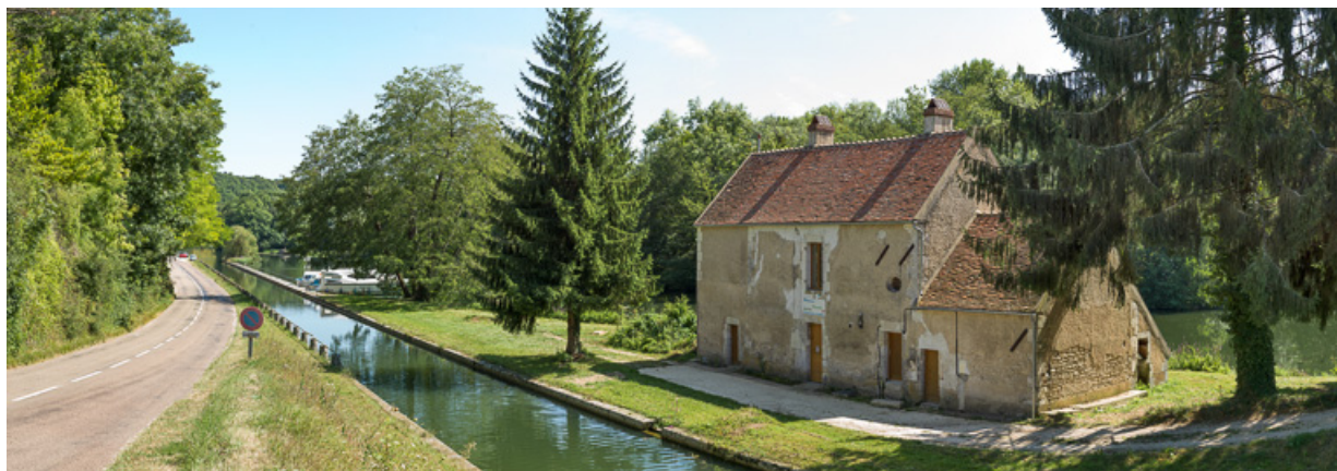
Vue générale de la maison de garde.
