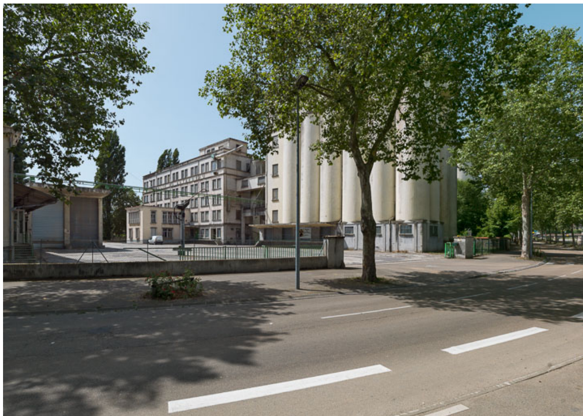
Les minoteries du « Moulin du Batardeau », bief 81 du versant Seine à Auxerre.
