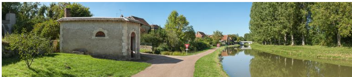
Vue d'ensemble du lavoir, avec l'allée de peupliers sur la rive droite.
