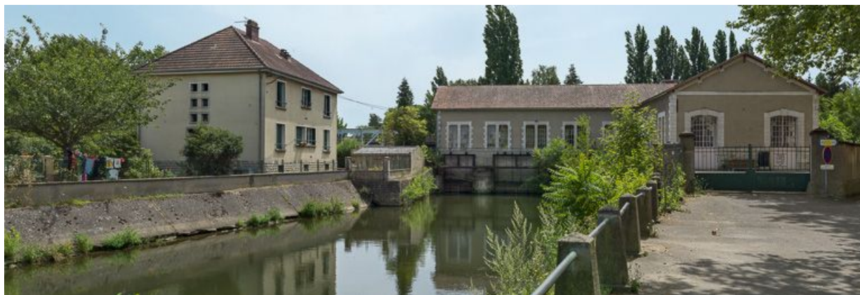
Le moulin et le bief de dérivation. A gauche, l'arrière de la maison éclésièrè.
