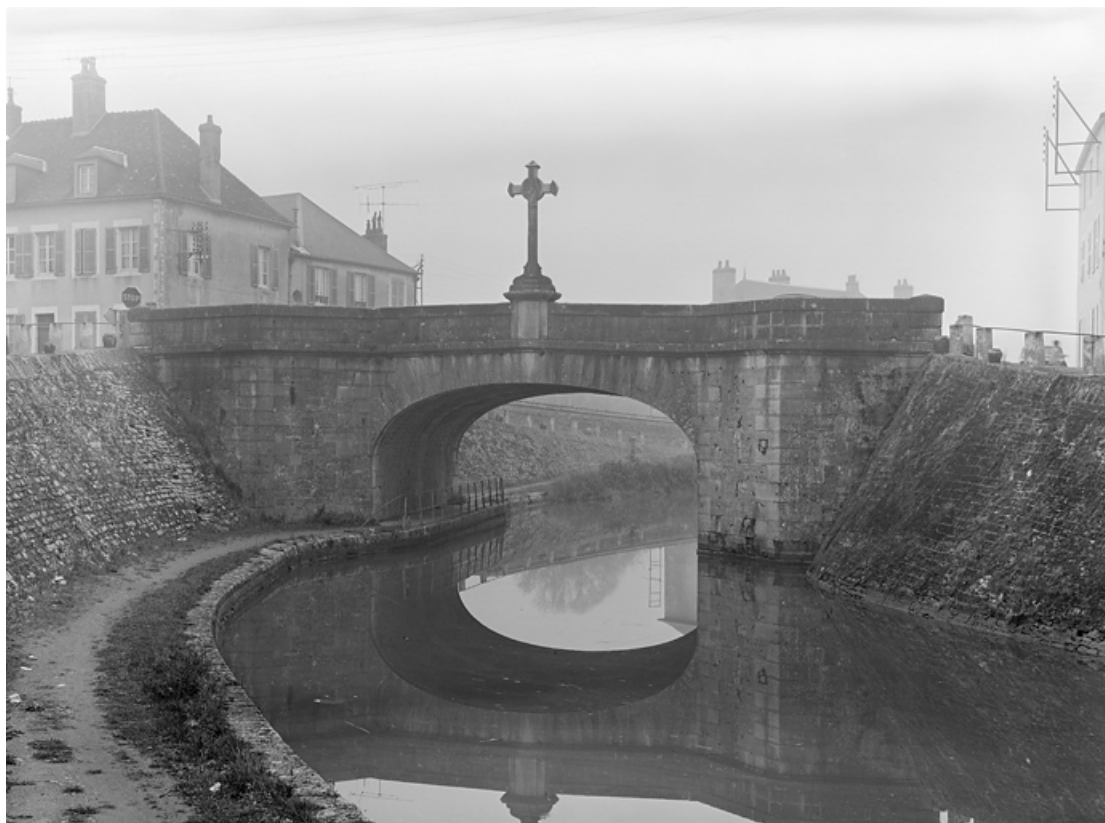
Vue d'ensemble depuis le chemin de halage.
