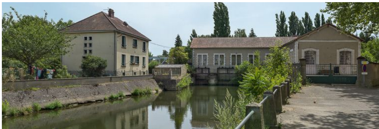
Le moulin et le bief de dérivation. A gauche, l'arrière de la maison éclésièrè.
