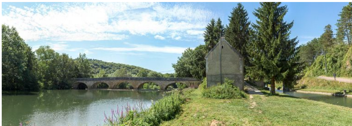
Vue générale avec à gauche, le barrage sur l'Yonne et à droite, la maison de garde.
