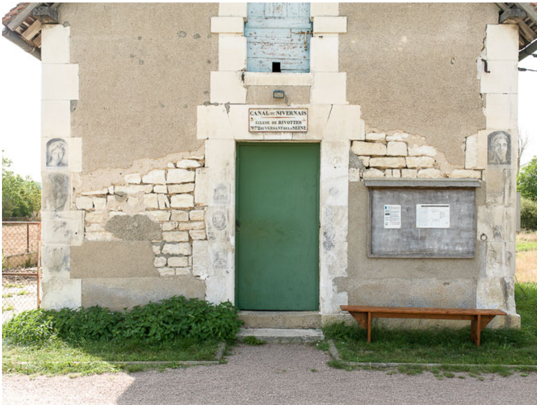
Maison éclusière. Détail du mur pignon, avec la porte d'entrée surmontée d'une fenêtre en plein-cintre. 89, Cravant, lieudit : bief 72 du versant Seine
