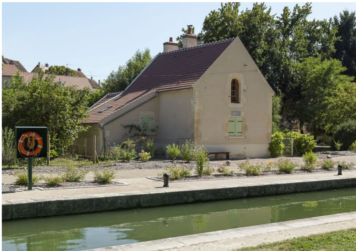
Vue de 3/4 de la maison éclusière et de l'annexe à gauche.
