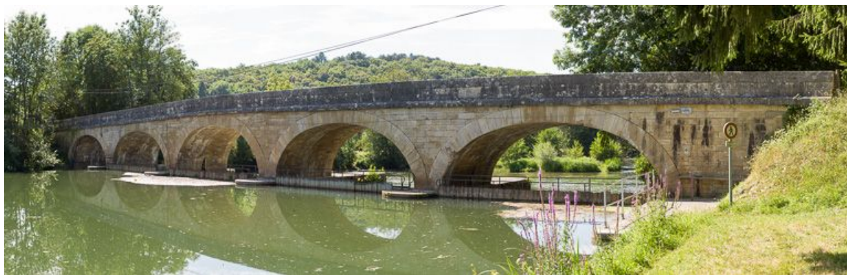
Vue générale du barrage à aiguilles sur l'Yonne surmonté d'un pont à cinq arches.
