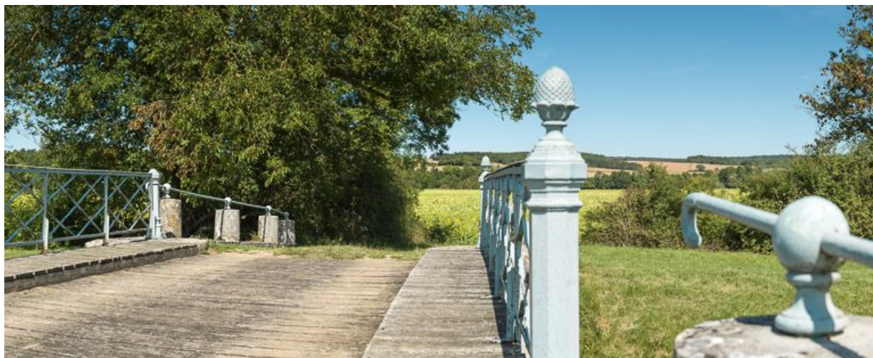
Détail du tablier en bois et des garde-corps en métal, avec pomme de pin.
