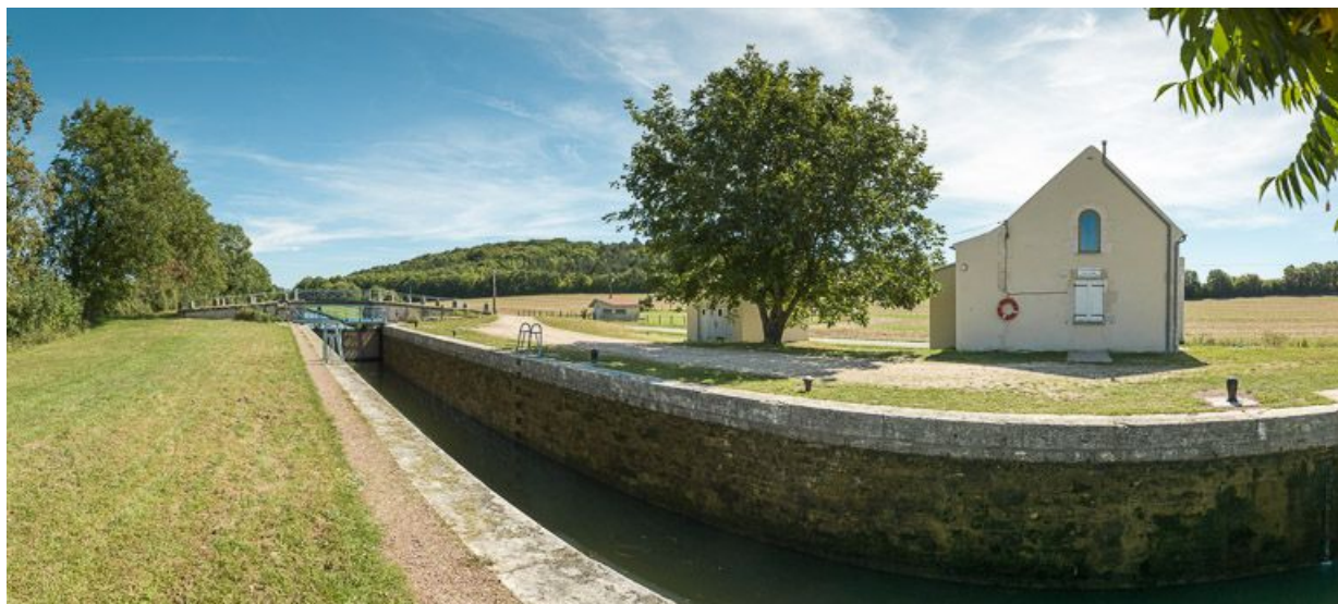
Vue d'ensemble du site avec maison éclésièrre de type Poirée de face.
