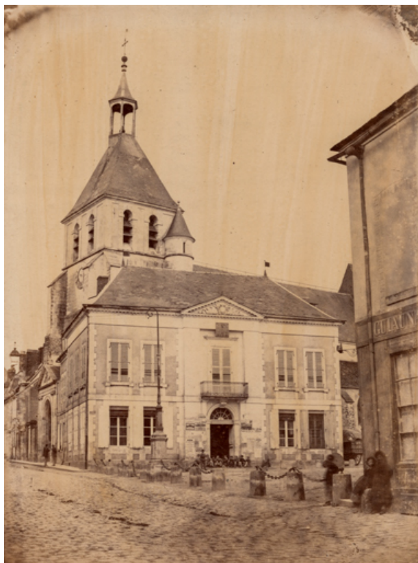
[Façade antérieure de la mairie, de trois quarts gauche]. S.d. [vers 1868]. 89, Brienon-sur-Armançon, 2 place Emile Blondeau
