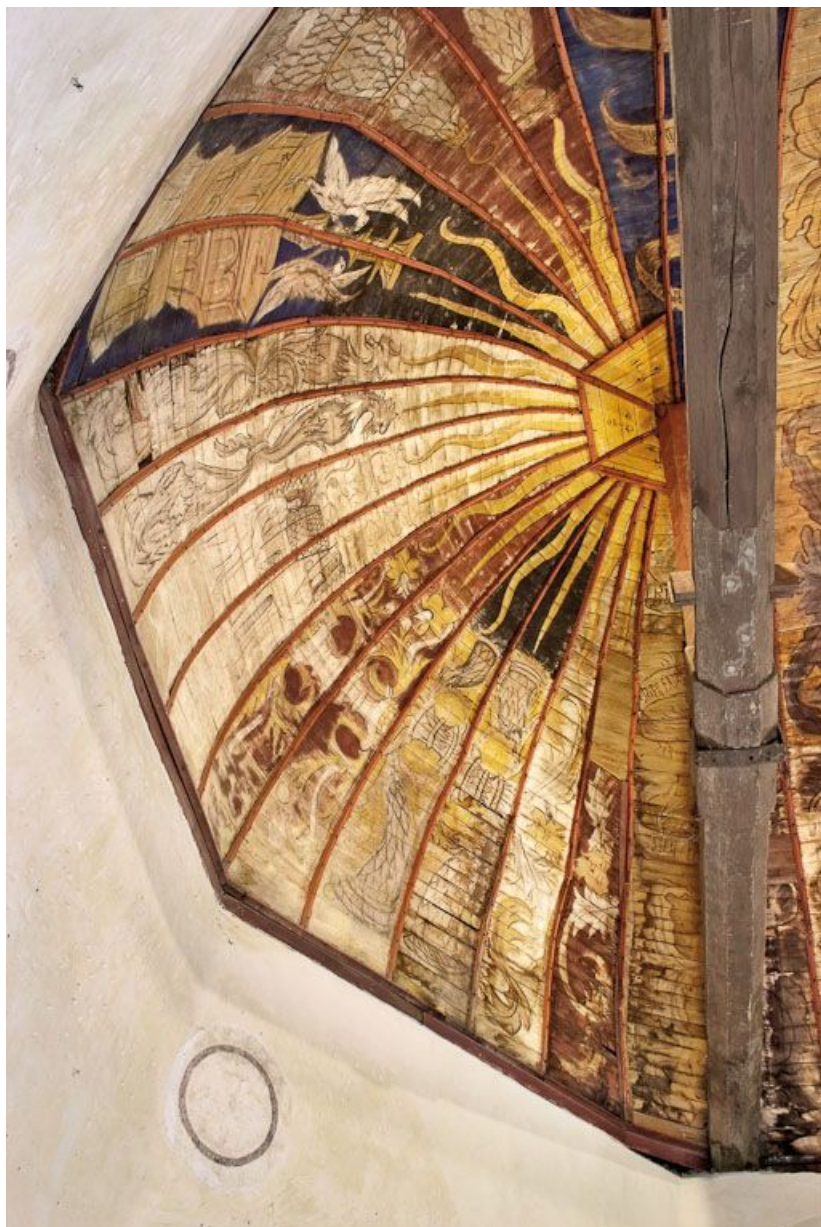
Détail de la voûte lambrissée et de ses décors peints.
