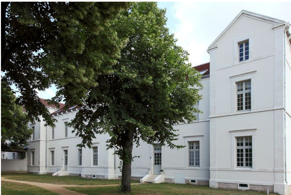
Ancien quartier des hommes, bâtiment postérieur de la troisième cour.
