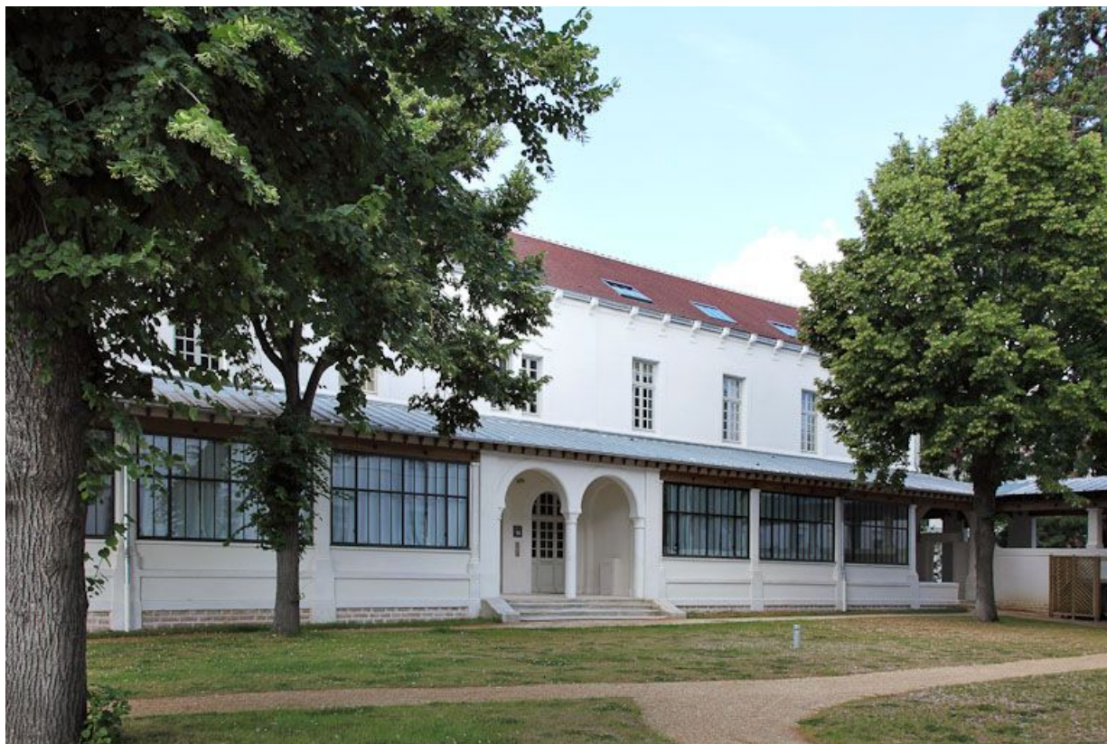
Ancien quartier des hommes, deuxième bâtiment, façade sur la troisième cour.
