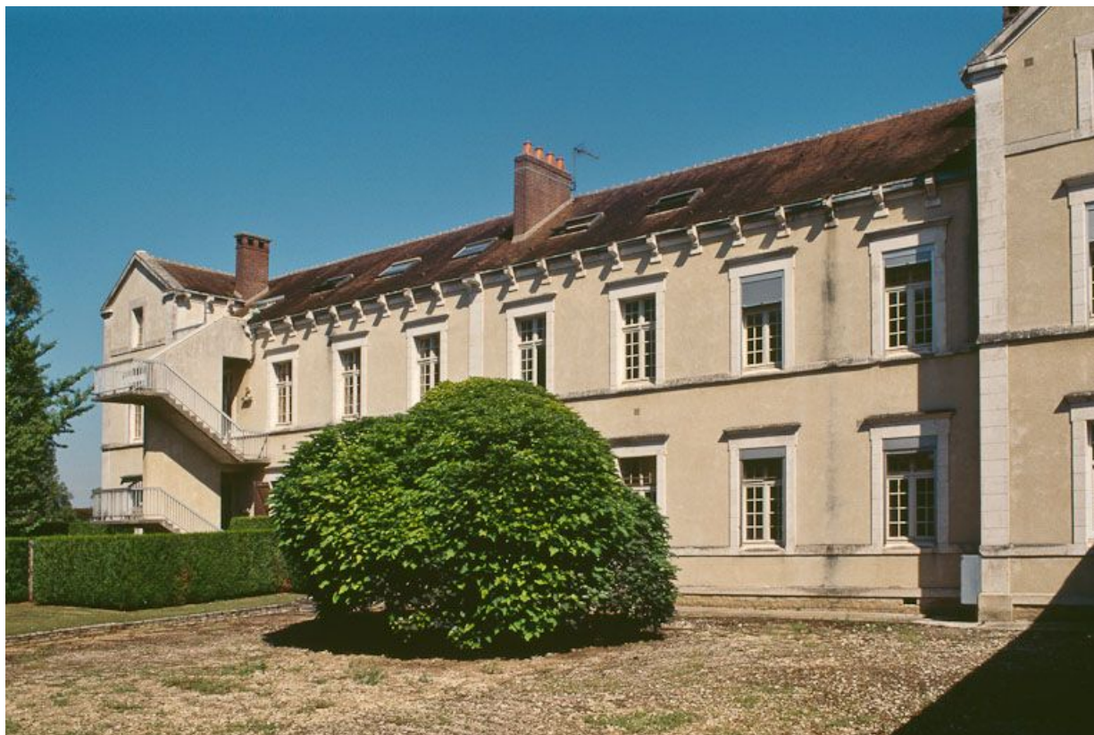
Quartier des femmes, bâtiment postérieur nord, façade ouest.
