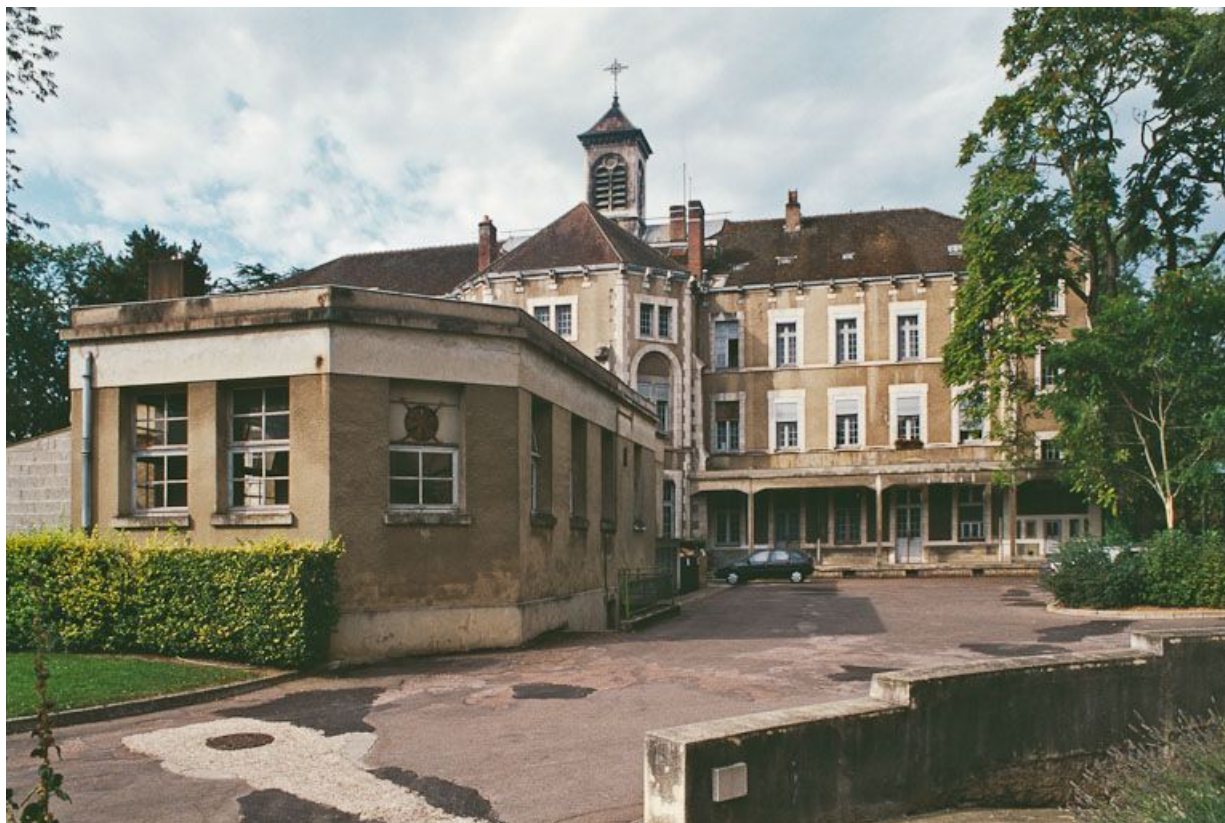
Bâtiment central, façade postérieure et cuisine construite en 1958 (1er plan).
