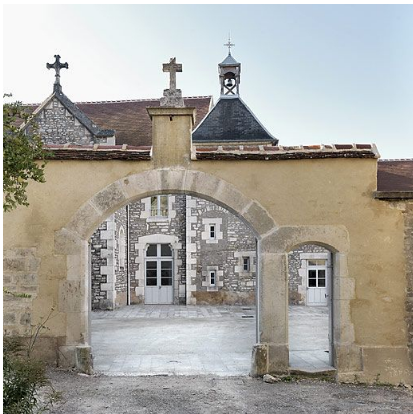
Vue d'ensemble depuis la rue du Couvent.
