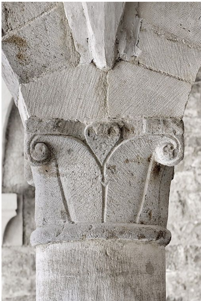
Salle voûtée, détail.
