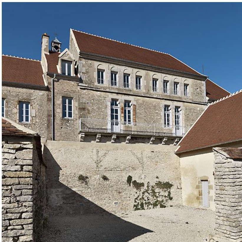
Façade postérieure du corps de bâtiment principal.
