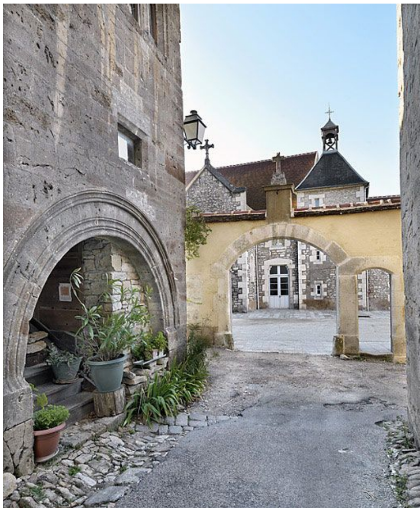
Vue d'ensemble depuis la rue du Couvent.
