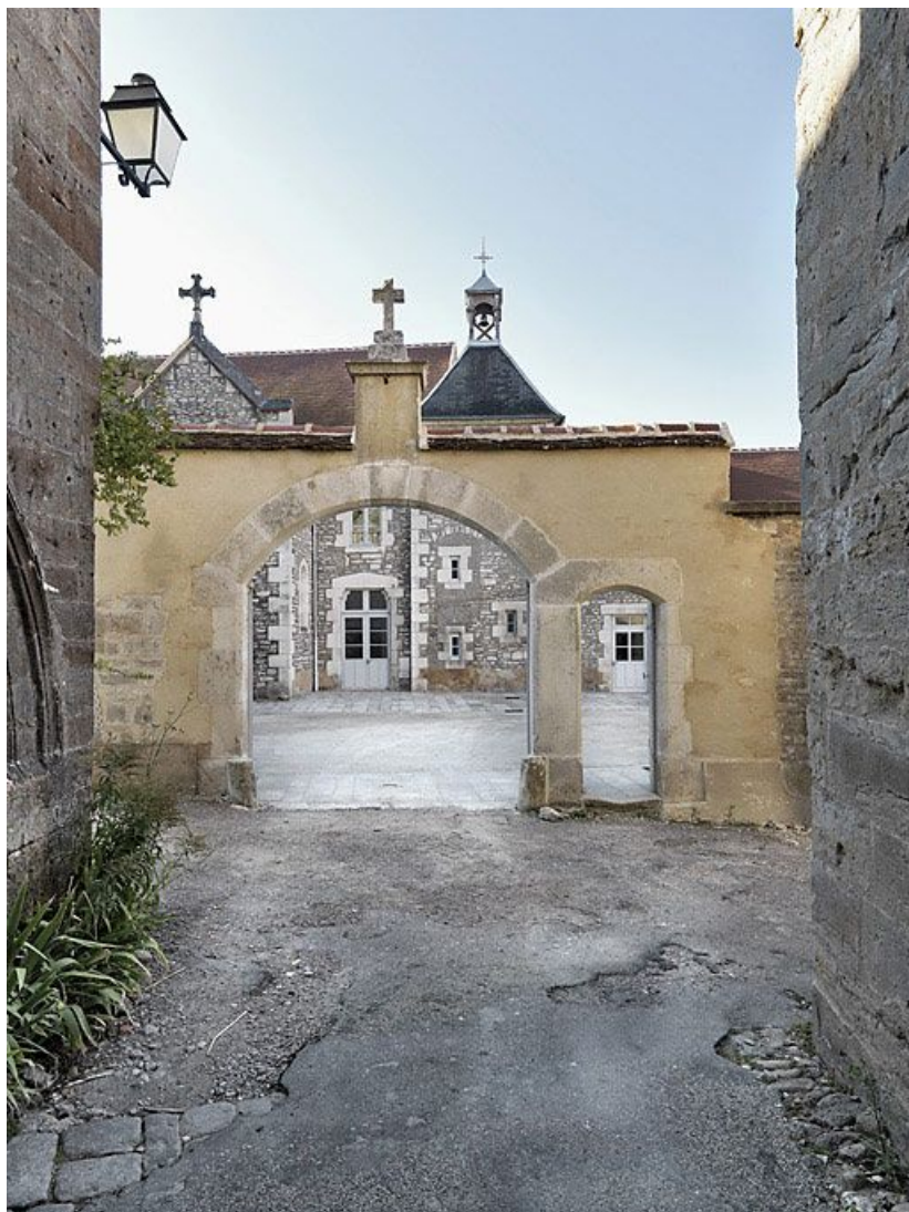
Vue d'ensemble depuis la rue du Couvent.
