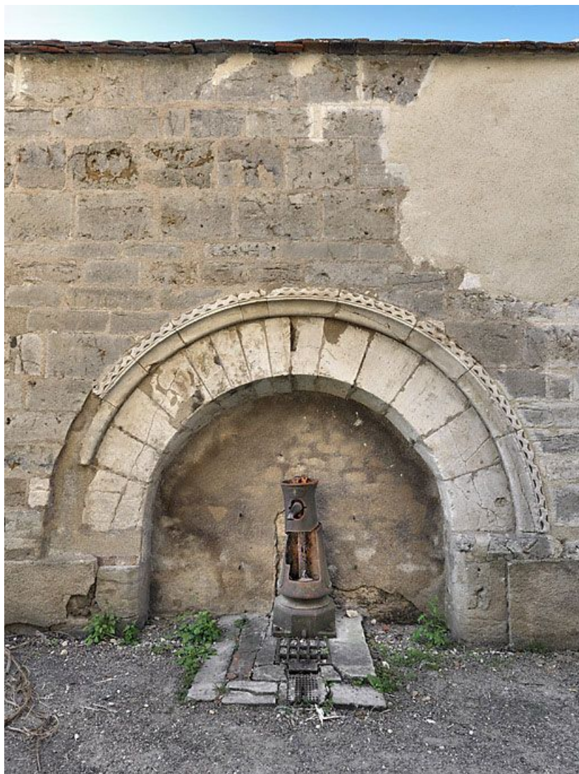
Fontaine dans le mur de clôture rue de l'hôpital.
