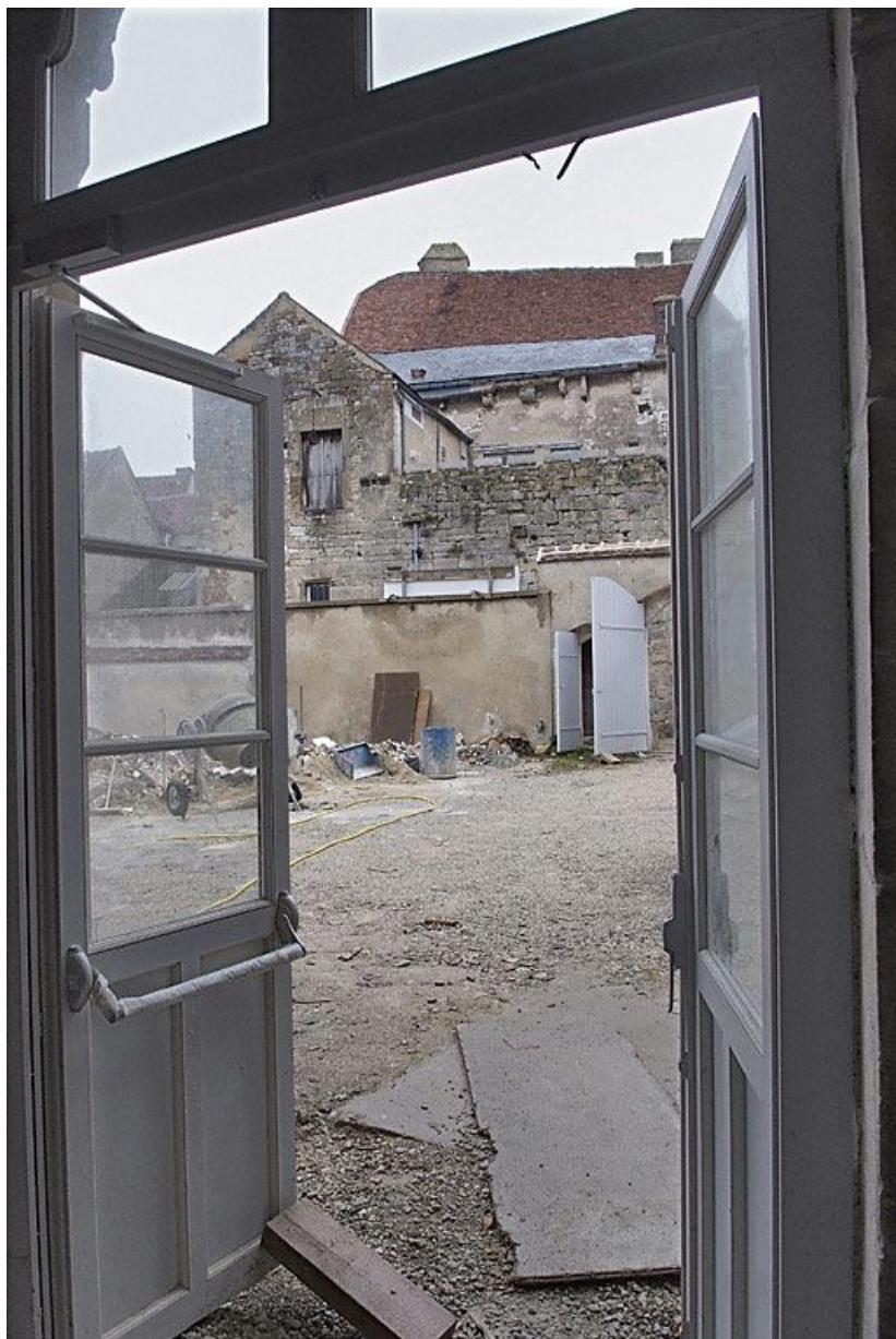
Vue de la cour pendant les travaux.
