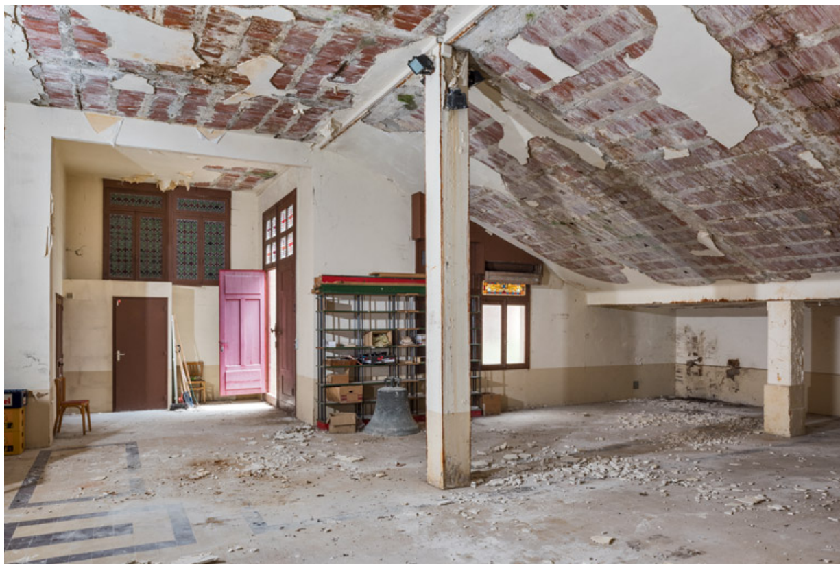
Crypte. Vue en direction de l'entrée est. 89, Migennes, 3 avenue Marcelin Berthelot
