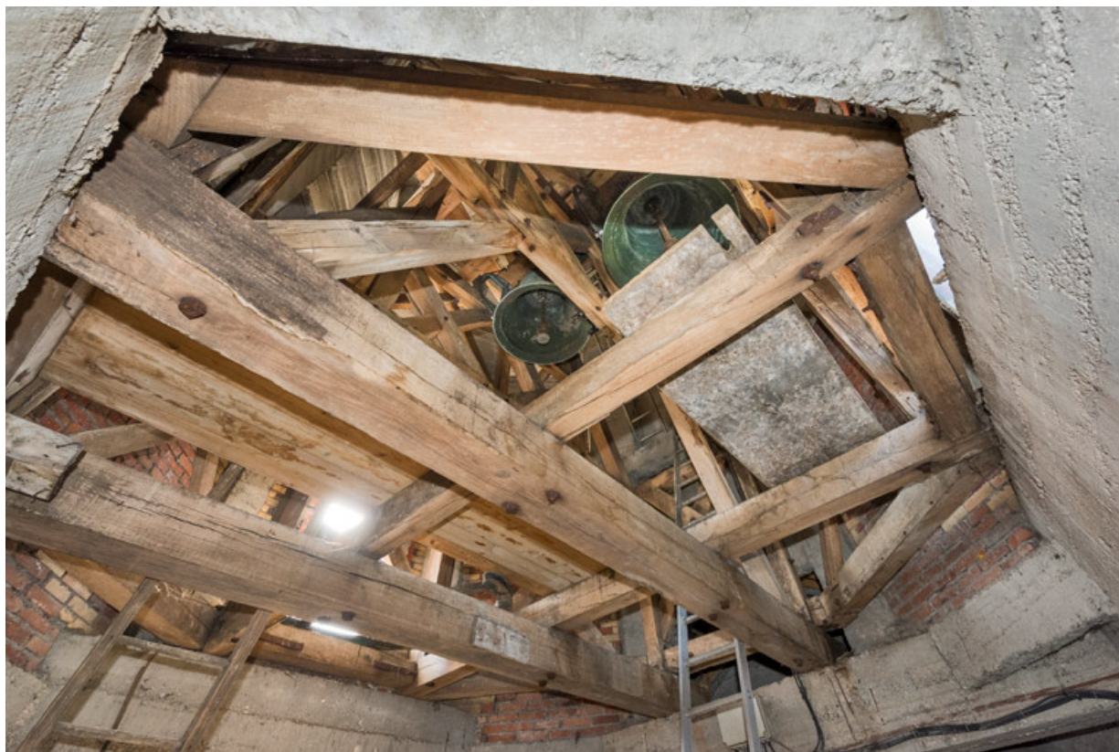
Enrayure de charpente du clocher. Vue en contre-plongée.
