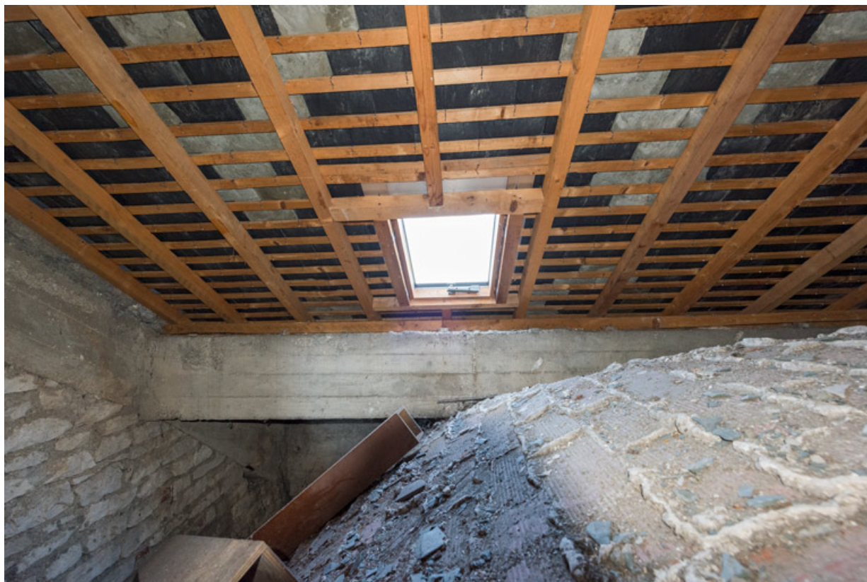
Voûte de la chapelle des fonts et charpente.
