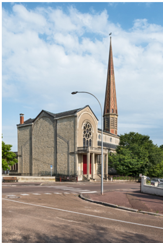
Transept. Vue d'ensemble, de trois quarts.
