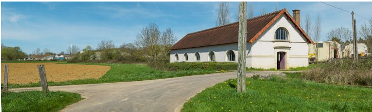
Vue d'ensemble du lavoir situé en contrebas du canal.
