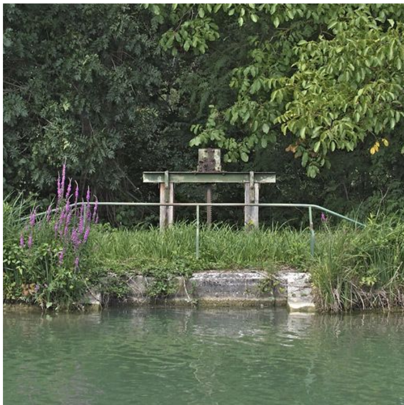
Le déversoir vu du canal : maçonnerie du déversoir, garde-corps et vanne.
