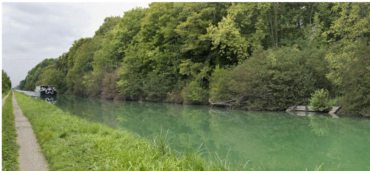
Le déversoir à droite. Au fond à gauche, pont IA89001050.
